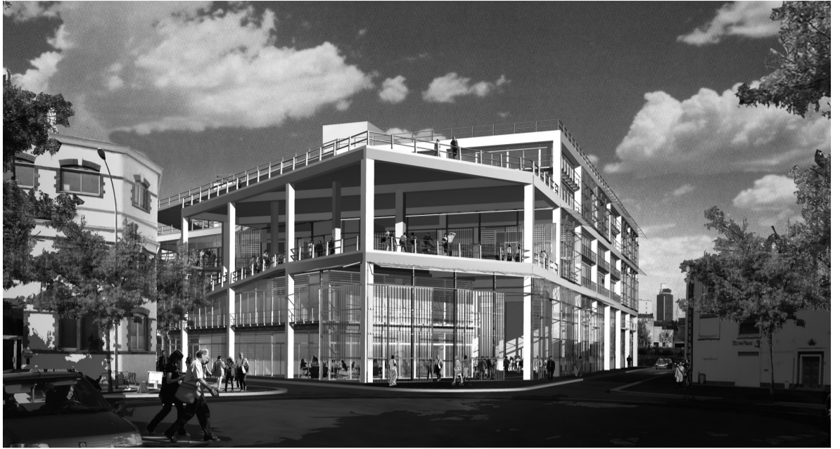
▲ Escuela de Arquitectura de Nantes, 2009
