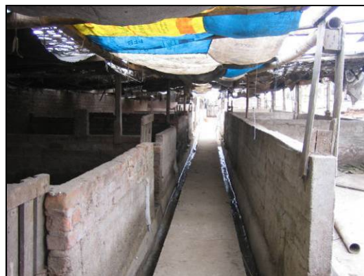
Figura 2.18 – Canals de recollida dels orins en corrals remodelats
