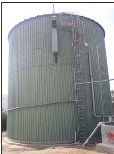
Figura 1.2 – Biodigestor CSTR de 750 m 3 a La Calera (Chinchá, Perú)
