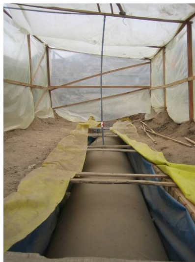
Figura 2.8 – Biodigester tubular de plàstic del Parque Porcino
