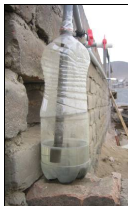
Figura 2.12 - Vàlvula de seguretat
