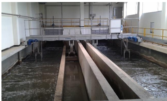
Il·lustració 7: Dessorrador i desengreixat. Font: https://estruagua.com/productos/puente-desengrasador-desarenador-longitudinal-longbri/
