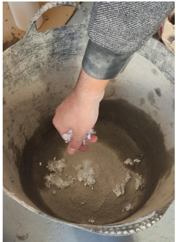
Figura 21. Fotografia del procés d'afegir la fibra de vidre a la gaveta amb morter
