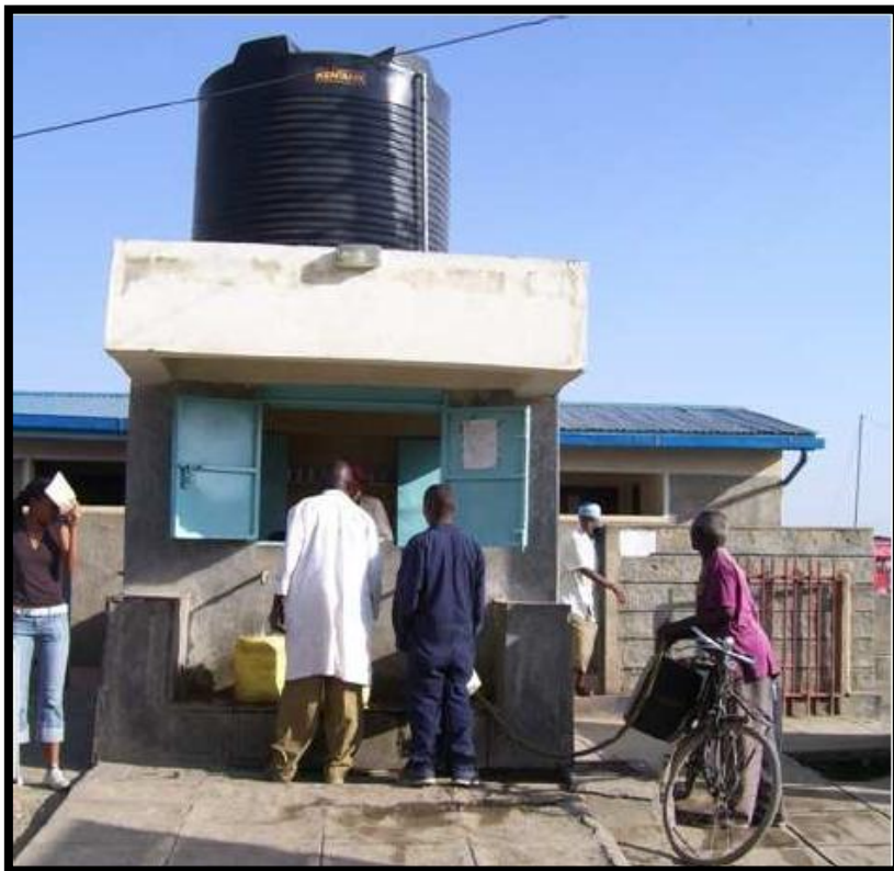
Ilustración 4.4. Usuarios del centro de distribución de Agua. Se puede observar el tanque de almacenamiento de agua de 5m 3 .
