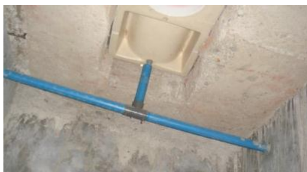
Ilustración 5.4. Ejemplo de tubería para la orina en el interior de un compartimento. (Ecosan Services Foundation (ESF), 2009)
