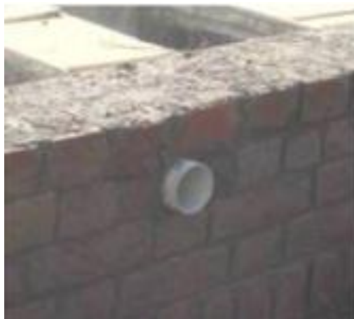
Ilustración 5.3. Ejemplo de colocación del tubo para la ventilación del compartimento. (Ecosan Services Foundation (ESF), 2009)
