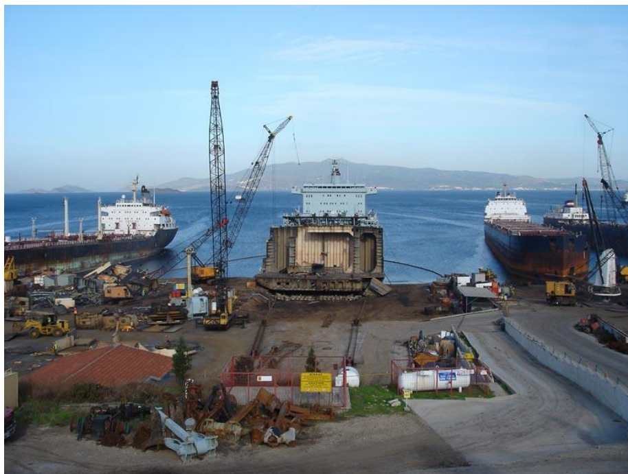
Ilustración 14: Vista del área de desmantelamiento de una instalación con buque amarrado al muelle
