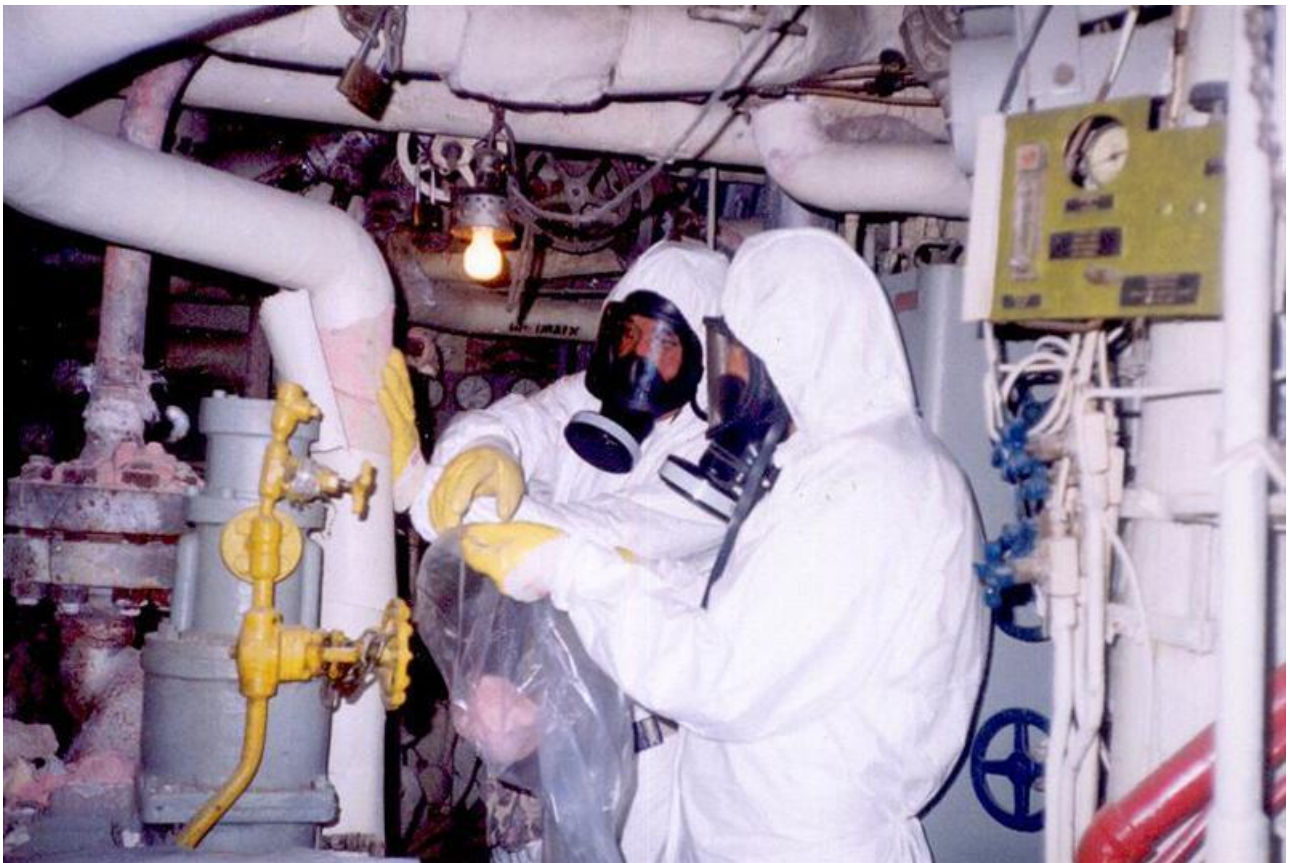
Ilustración 10: Vista de equipo de protección para extracción de asbestos
