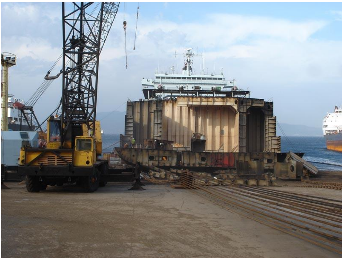
Ilustración 20: Vista de la estructura del buque medio desmantelada
