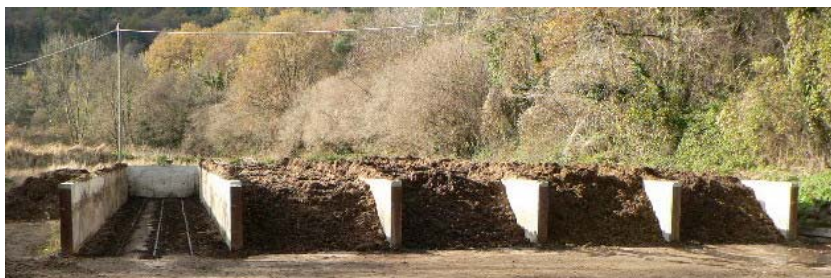
Foto 3. Sitges de compostatge de deshidratat de purí de vacum (Cooperativa La Fageda - Santa Pau). Les sitges es construïren per aprofitar millor la poca superfície disponible.
