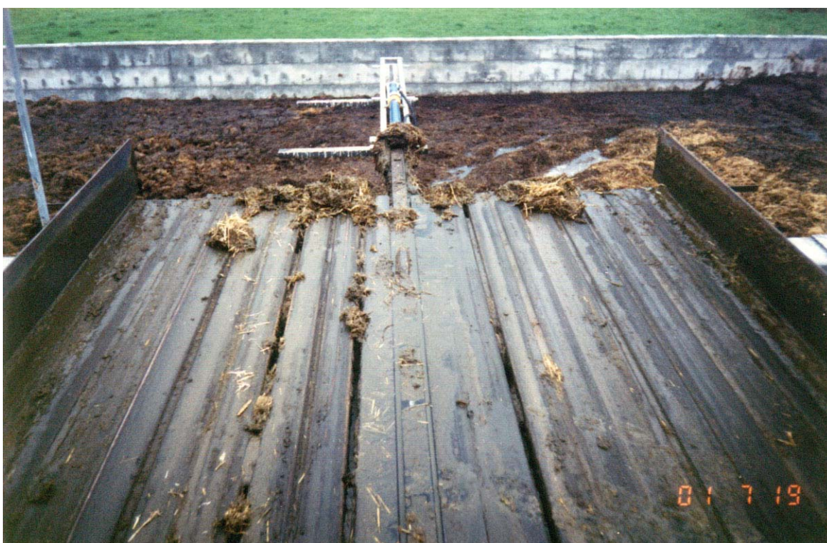
Figura 2. Tamís format per un tramat de biguetes en T separades uns 3-4 cm, i situat al final del passadís. La fracció líquida s'esmuny a un fossa situada sota del tamís i separada per un mur del femer, on cau la fracció sòlida.
