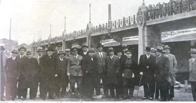
[Fig.5a] Inauguración del Puente de Astilleros en 1931. 1938.
