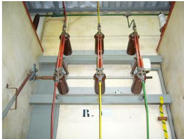
Figura 10.4: Alimentación de los rectificadores trifásicos
