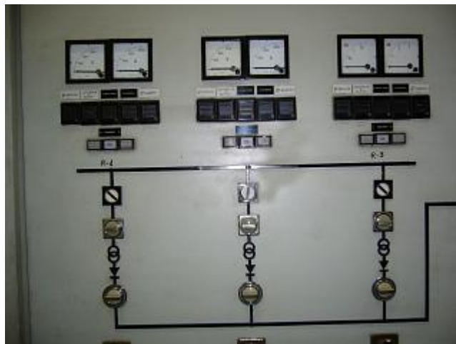
Figura 10.5: Puerta de los rectificadores con esquema explicativo
