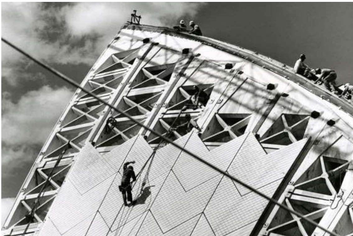
Imagen 56: instalación de las baldosas sobre la cubierta.
