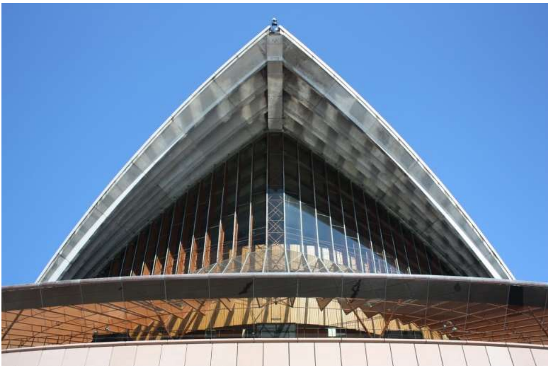
Imagen 60: unión entre muro de vidrio y cubierta, donde se puede apreciar la diferencia de ángulo de todas las piezas de vidrio.
