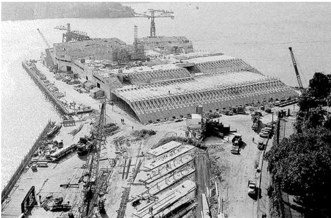
Imagen 48: imagen aérea del podio cuando aún no se había comenzado la cubierta.
