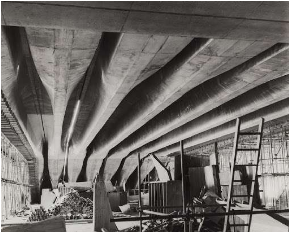
Imagen 49: detalle de las vigas que soportan el podio, donde se aprecia la forma, la luz y como estas son dobladas.
