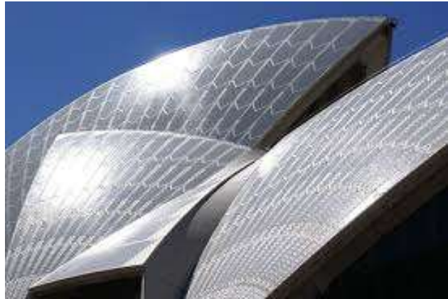
Imagen 57: cubierta terminada donde se puede ver el efecto de la luz sobre esta.
