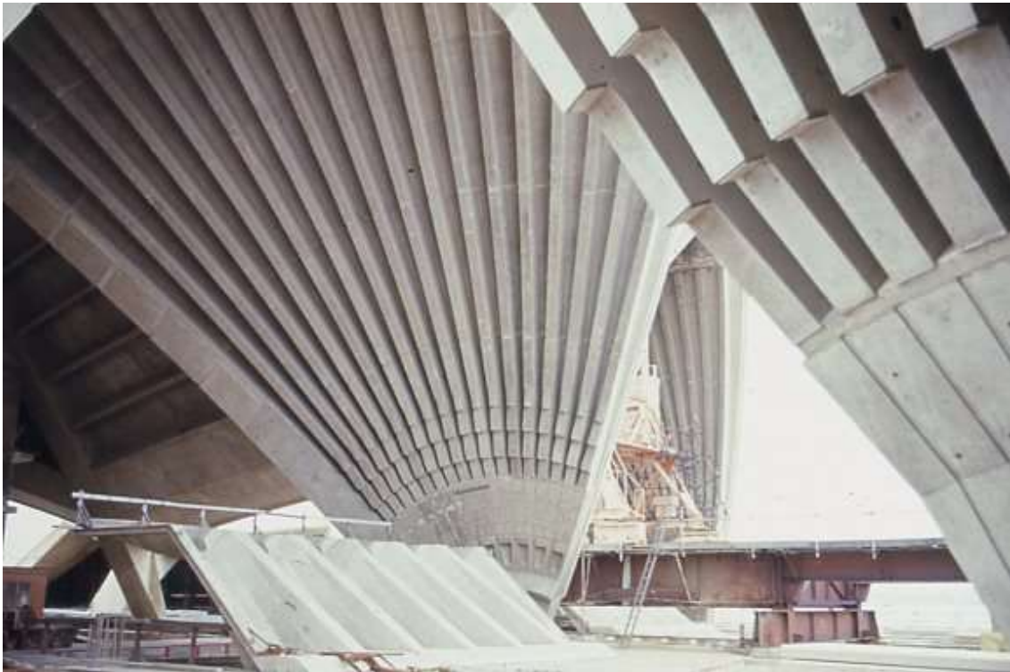
Imagen 46: detalle de un punto de unión de vigas de la estructura de la cubierta.
