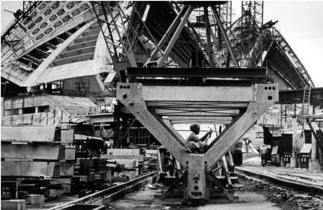
Imagen 53: manipulación y transporte de una de las piezas prefabricadas de la estructura.
