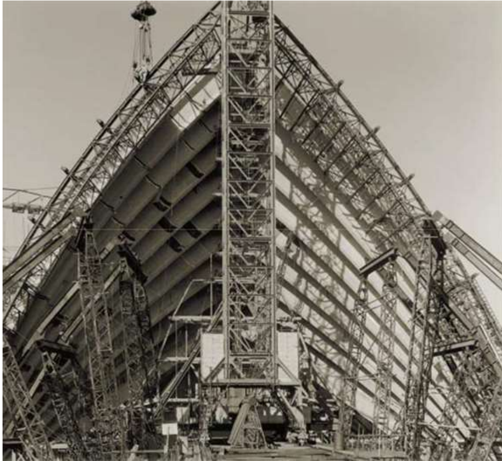
Imagen 52: estructura empleada para soportar las cubiertas durante el proceso de construcción.
