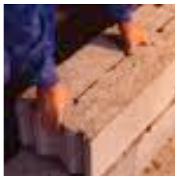
Figura 4.20: Aplicación del Arliblock y muro portante con altura máxima 3 m
