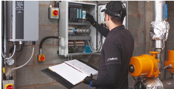
Fig 2. Mantenimiento preventivo de baja tensión como parte del Hard FM (fuente: Bellrock Group, “Facilities Management – The Differences Between Soft FM and Hard FM”, 2019).
