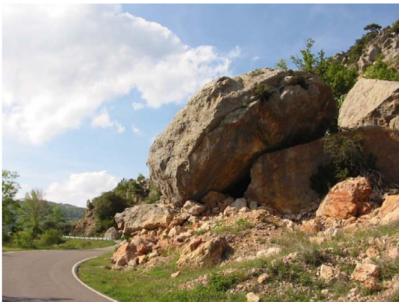
Fotografia 3. Un aspecte dels blocs caiguts sobre la carretera
