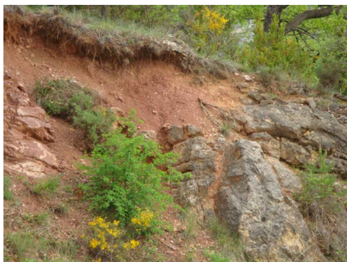
Fotografia 8. Aspecte de la bossada càrstica de la Vall del Mig, al tall de la carretera
