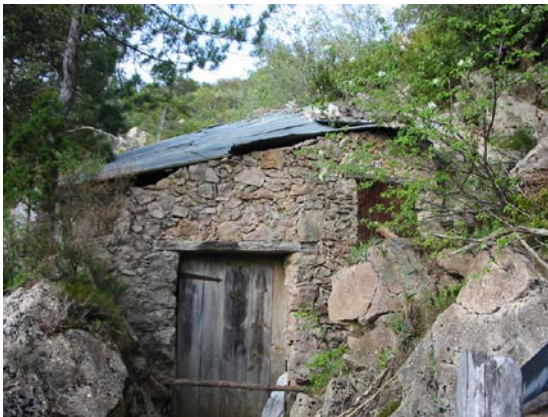
Fotografia 4. Entrada a una de les cabanes
