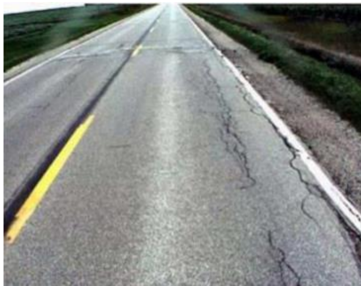
Figura 4. Pavimento fisurado.
