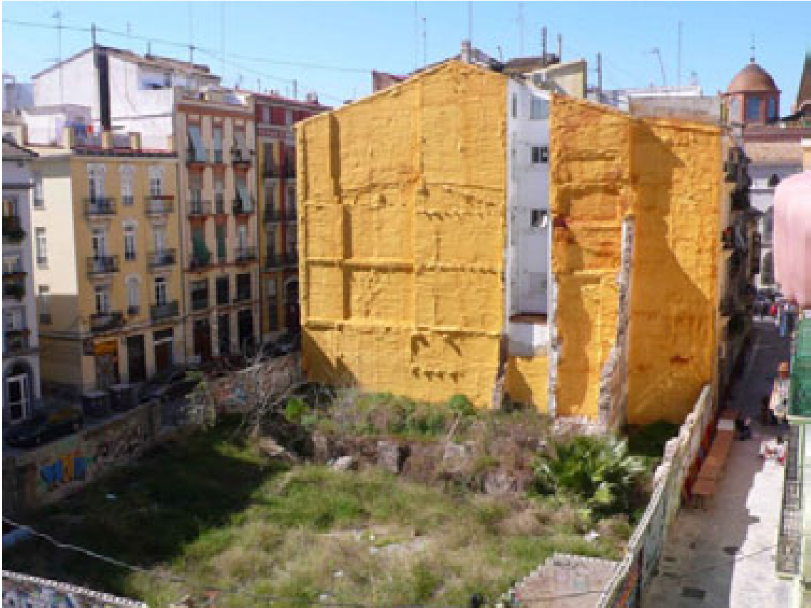
Estado previo. Foto 2010
