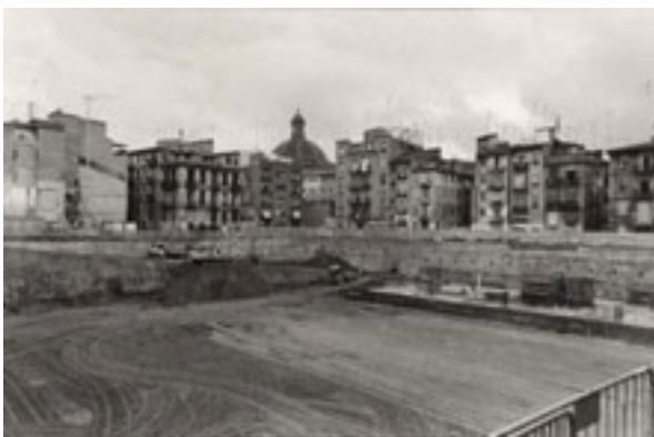
Solar y excavación para EASD, 2000
