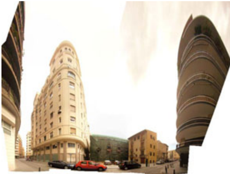
Foto tomada en las traseras de la avenida del Oeste hacia el barrio. Demoliciones y sustituciones resultado de la Apertura del Oeste. Construcción de nueva planta a escasos 4 metros de la trasera de la avenida del Oeste. 2012.
