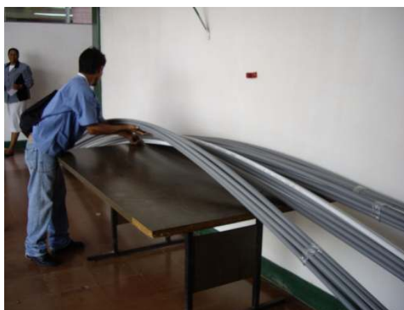
Fig.17 Descargando los tubos de la camioneta
