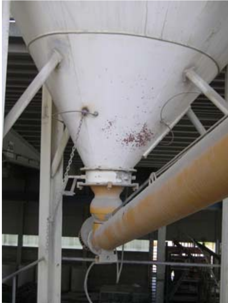
Part inferior d'un dels sils de formigó.
