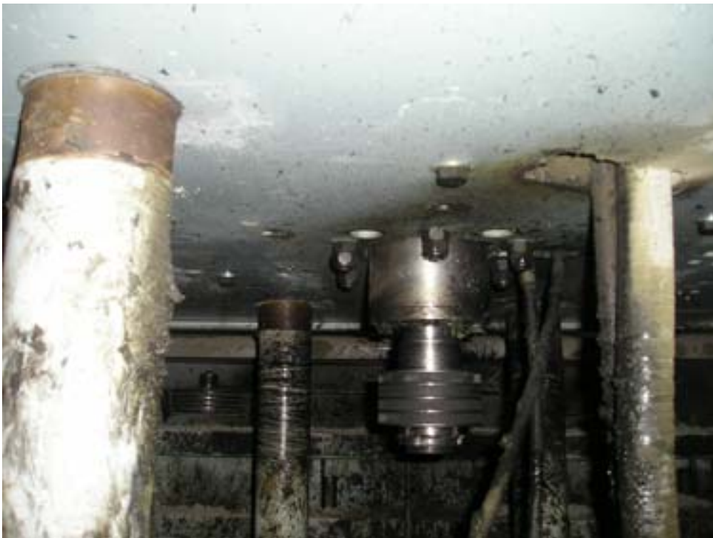
Imatge d'un dels vibradors ubicats a la base.
