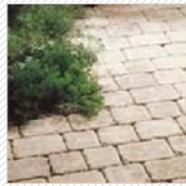
pavimento exterior de piedra en la zona de rampas
