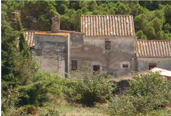
Fachada posterior de la casa
