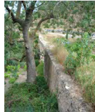
Vista lateral del puente
