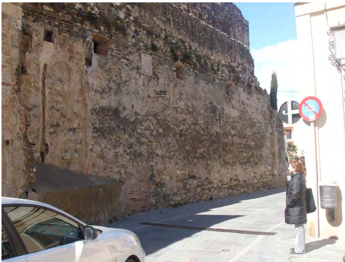
Vista de los restos del Molino de la Canal: Desde la plaza San Andreu
