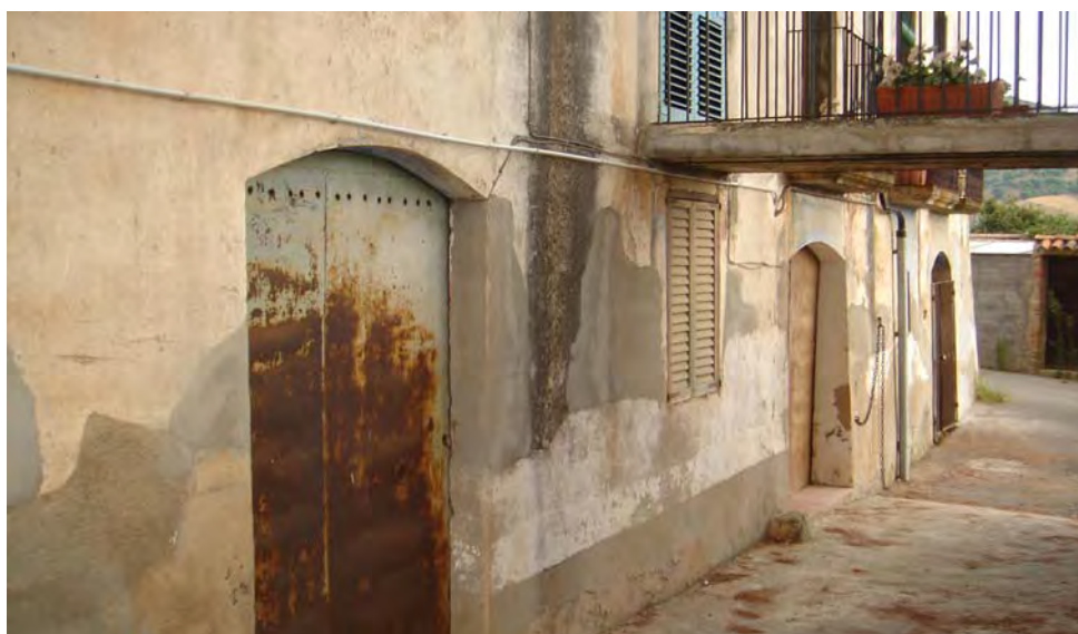
*Paso bajo pasarela acceso vivienda planta piso.
