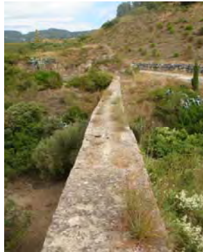
Vista cenital del puente
