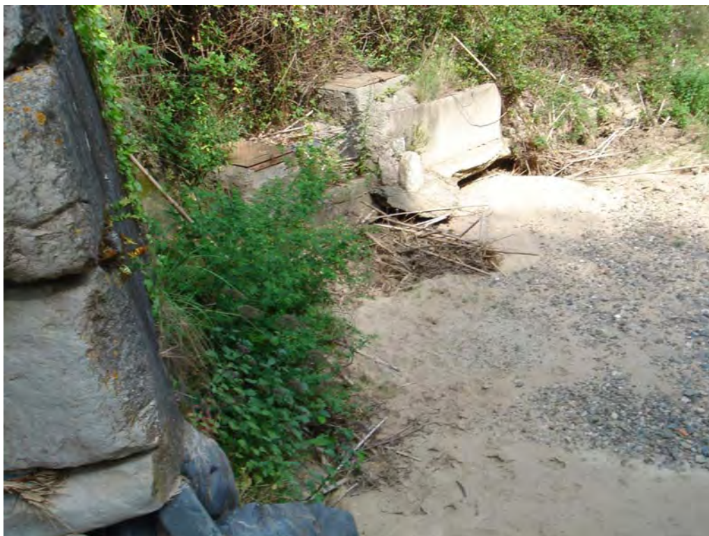
*Imagen de la zona: comprobación física de los restos existentes
