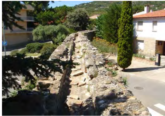
Vista cenital del puente
