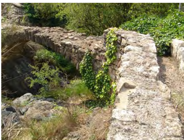
*Vista de la canalización que llega al puente.
