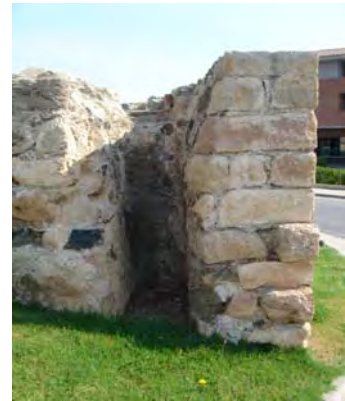
Canal de salida de agua
