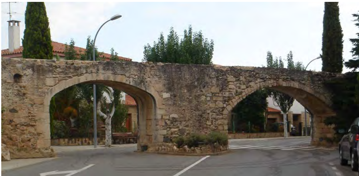
*Vista principal de los puentes: a la derecha queda el castillo del Paborde
