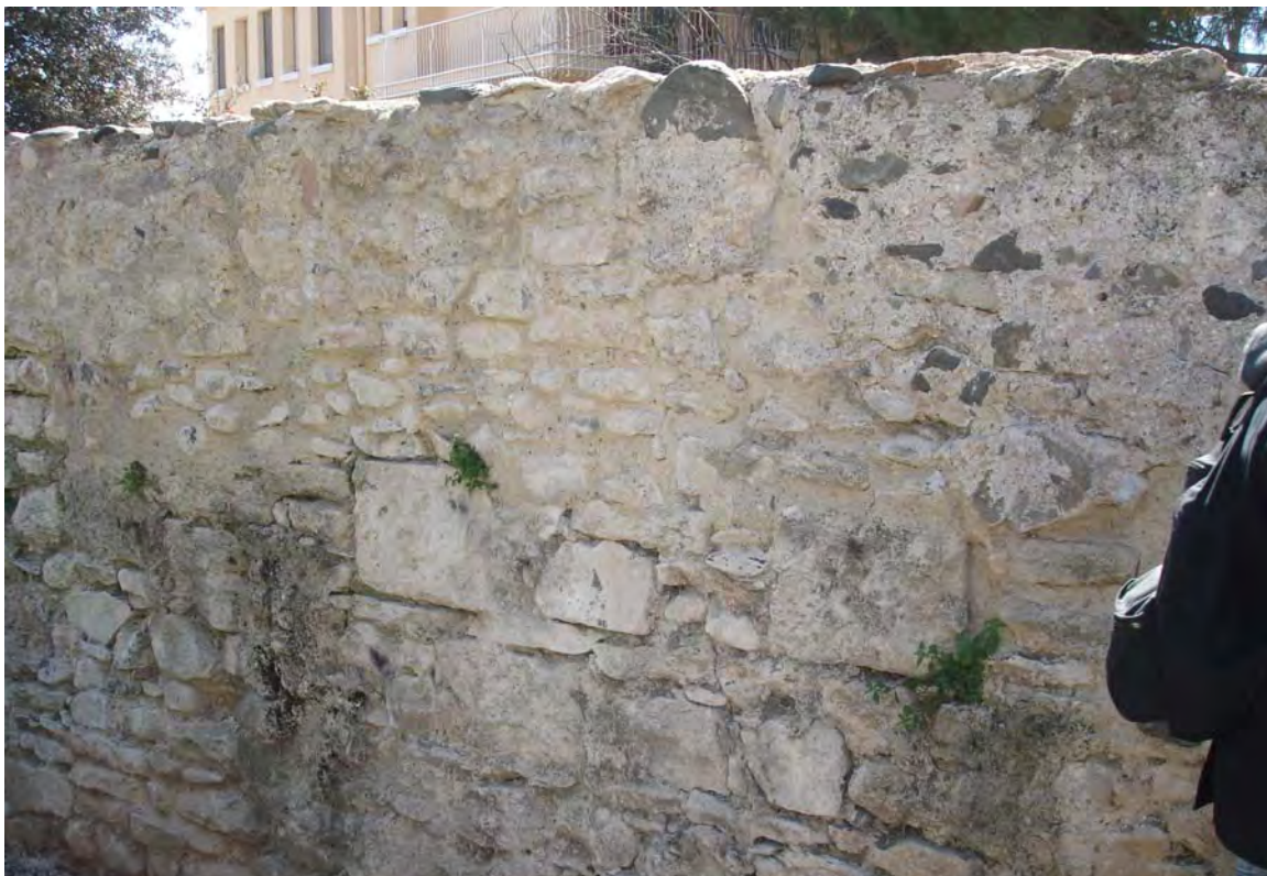
*Detalle de muro de piedra "dels Ponts".
