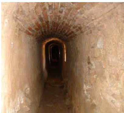
Canalización del molino de la Canal
