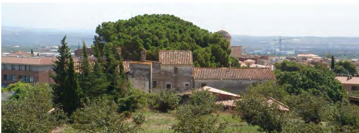
*Fachada posterior: Estado actual (2009)
