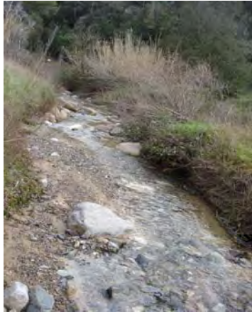
Estado actual del Rec de la Vila
