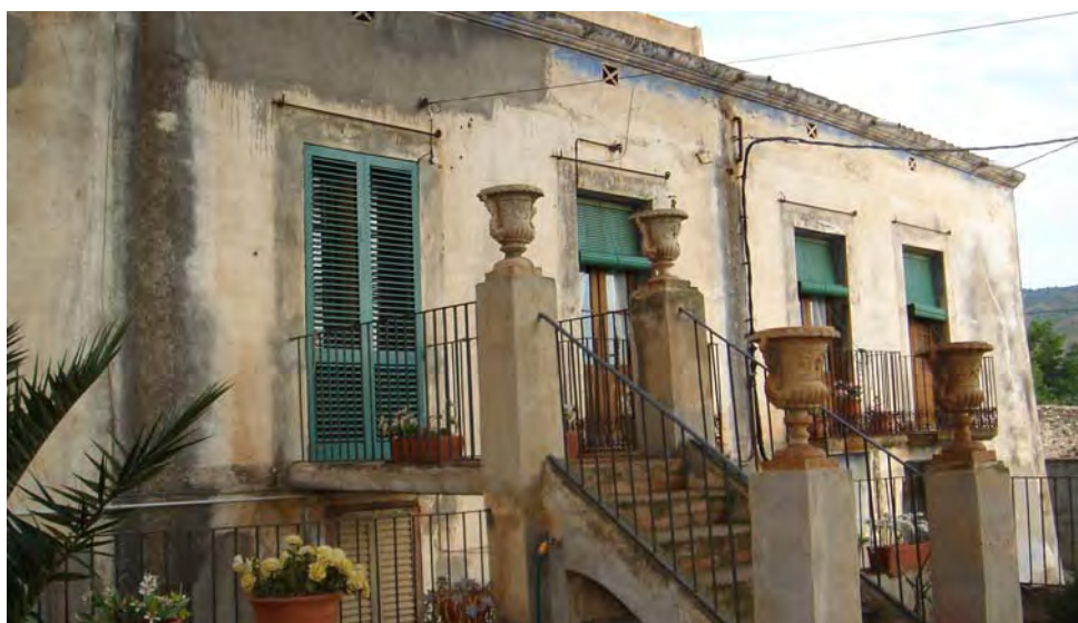
*Detalle fachada principal: pasarela de acceso vivienda planta piso
