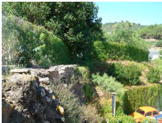
*Parte del muro y/o canalización en la parte posterior
