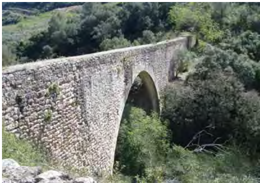
Vista lateral del puente
