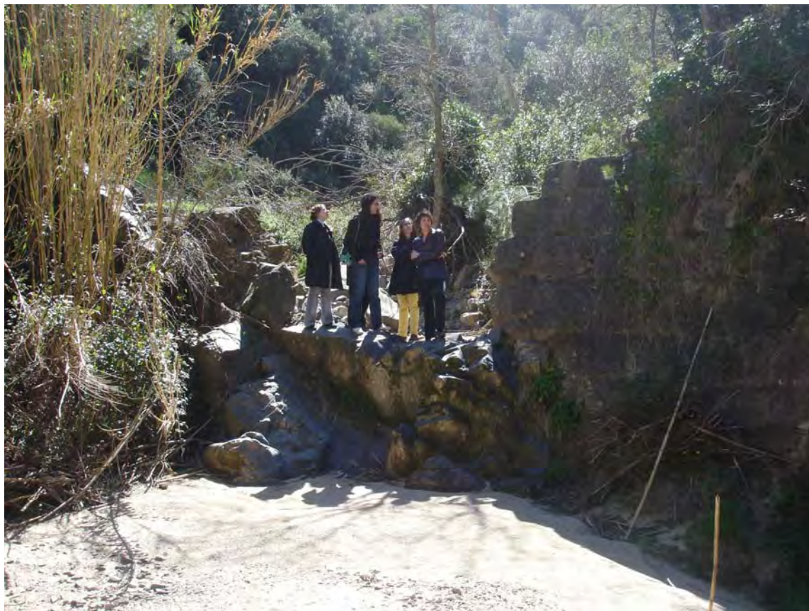
*Visita a los restos de la “Resclosa”, acompañados de la Sra. Montserrat Soronelles y la Srta. Montserrat d’Aroca
