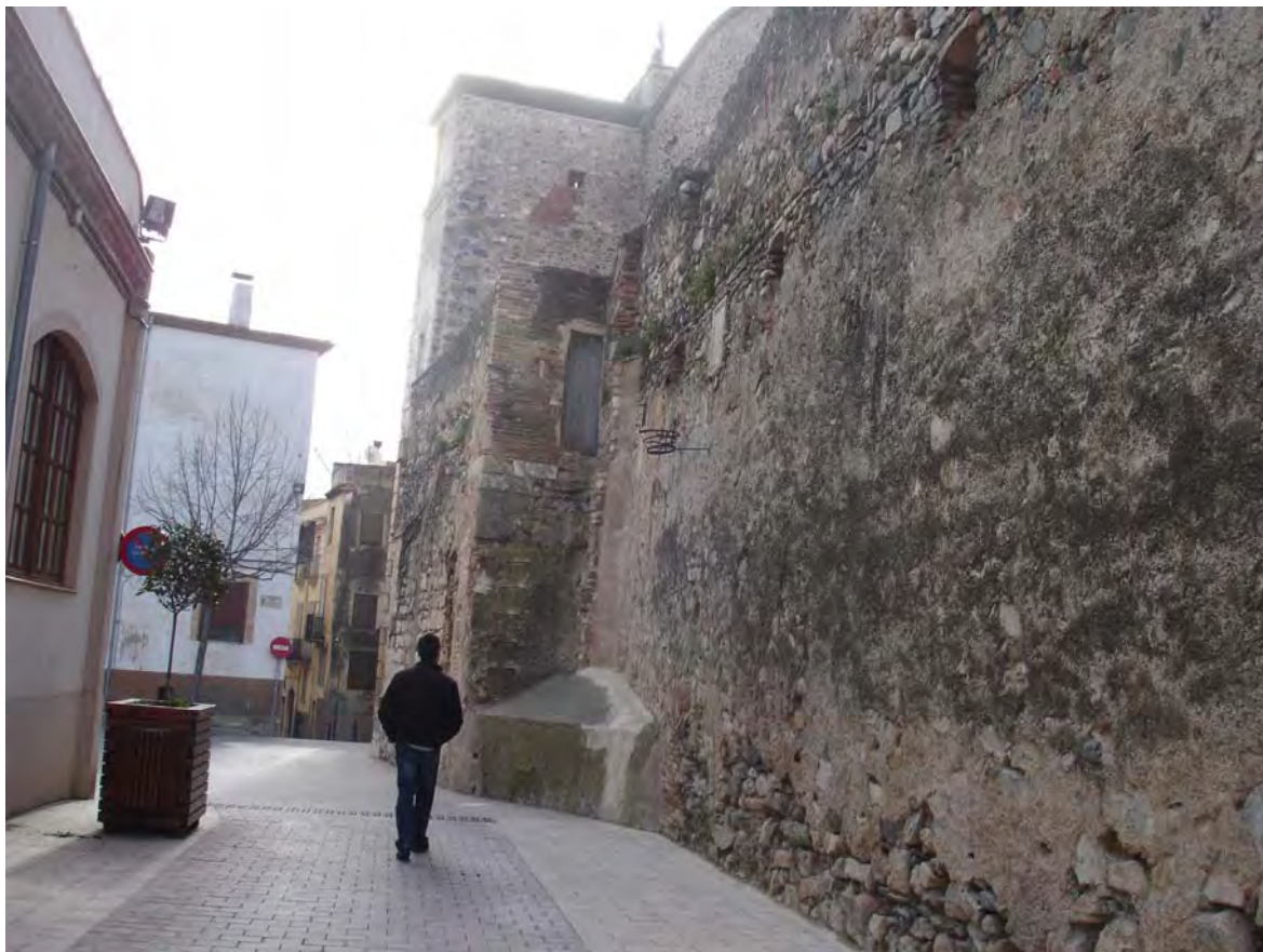
*Dirección de bajada por la calle Mayor, con la muralla del Castillo de Paborde a la derecha. Unos metros más adelante los restos visbles desde el exterior del molino.
