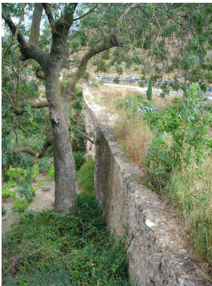
*Vista superior del puente, transitable sin medidas de seguridad.
