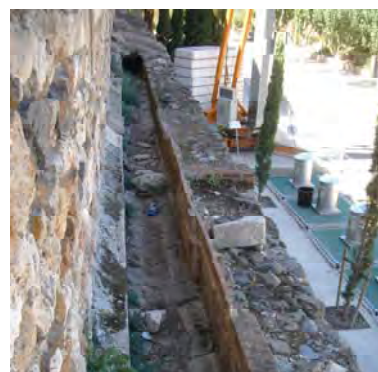
Canalización de molino
