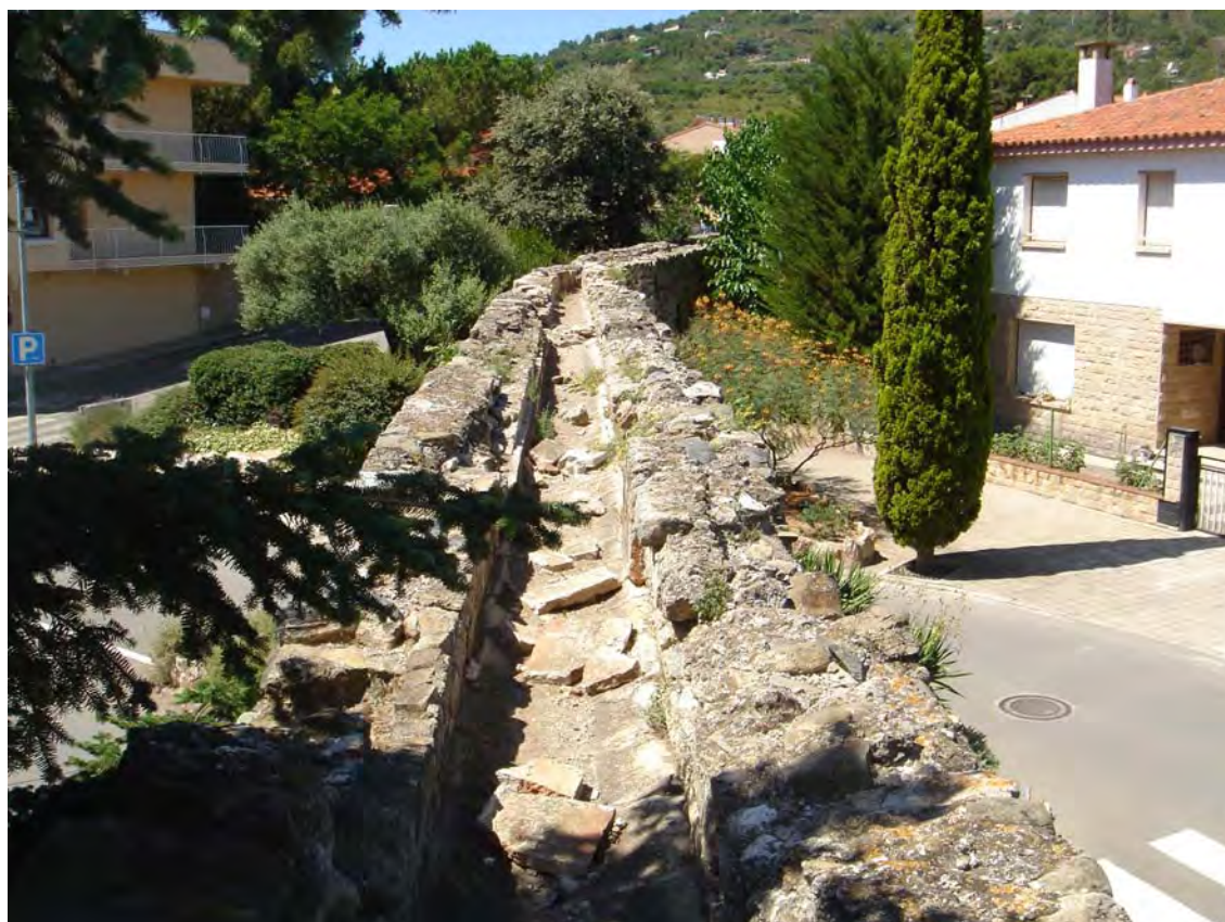
*Canalización sobre los puentes.
