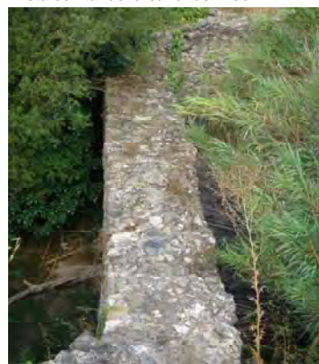
Vista cenital del puente
