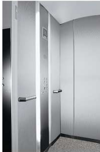
Interior de la cabina, con acabados de última calidad.
