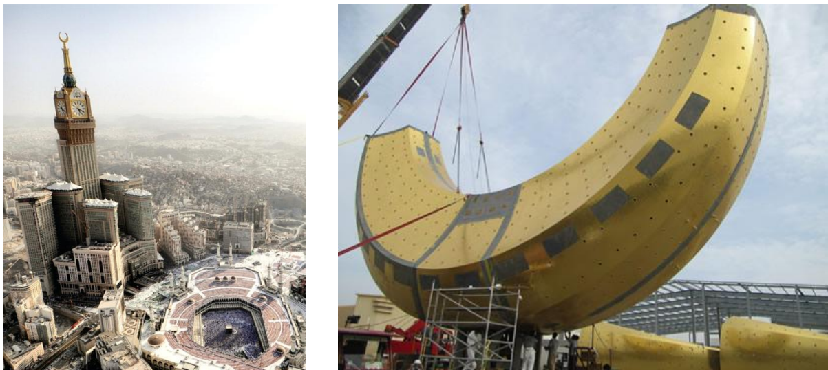
Fig. 36 y 37.- Vista general y detalle de estructura de coronación.
