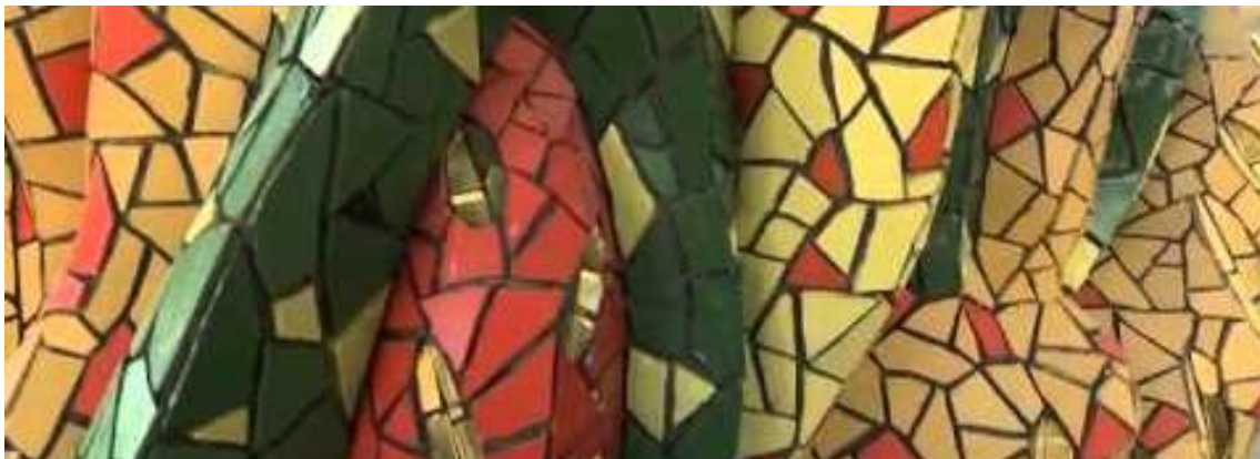
Fig.7.- Técnica del trencadís empleando piezas de vidrio opalino.
