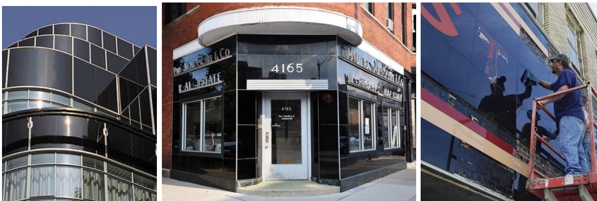
Fig.8,9 y 10.- Aplicaciones del Vitrolite en revestimiento de fachadas
