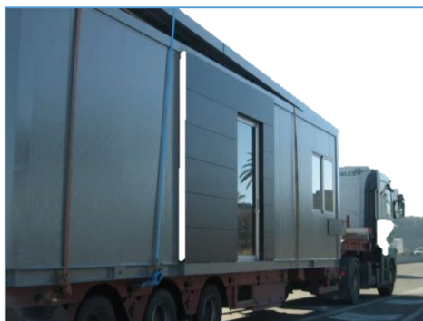
Il·lustració 25: Transport d'un mòdul amb camió
