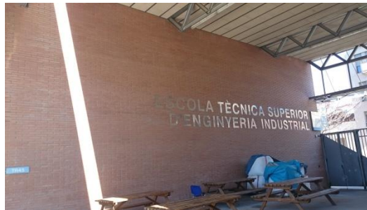
II-lustració 32: Fotografia de la façana TR45_SUD
