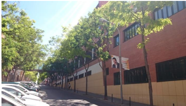
II-Il·lustració 19: Fotografia de la façana TR4_NORD
