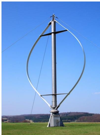
Figura 3.7 Aerogenerador d'eix vertical de rotor Darrieus. Font: Ecotimeblog [8]
