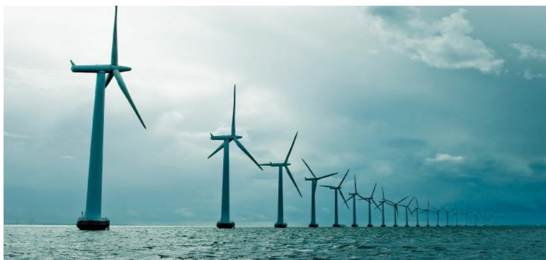
Figura 3.14 Parc eòlic offshore . Font: TESICNOR [16]
