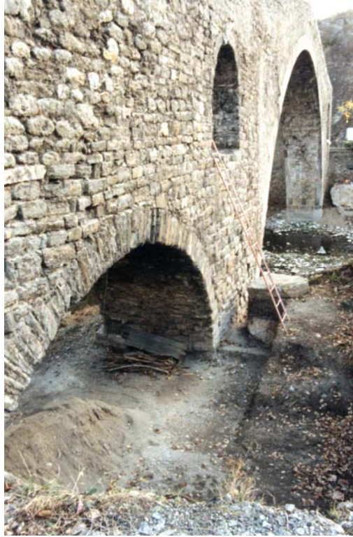
Imagen 1.7 Vista del paramento visto desde aguas abajo y orilla derecha, durante los trabajos de restauración por el Servei de Monuments de la Diputació de Girona en 1996. 11
