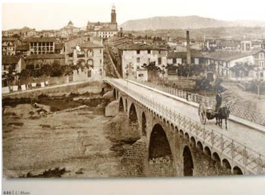
Imagen 4.10 A la izquierda: el puente visto desde la orilla derecha después de la ampliación de ancho de la calzada en años veinte del siglo XX. L'Abans
