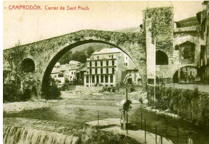
Imagen 2.11 Estado del paramento visto desde agua abajo en los años cuarenta del siglo XX
