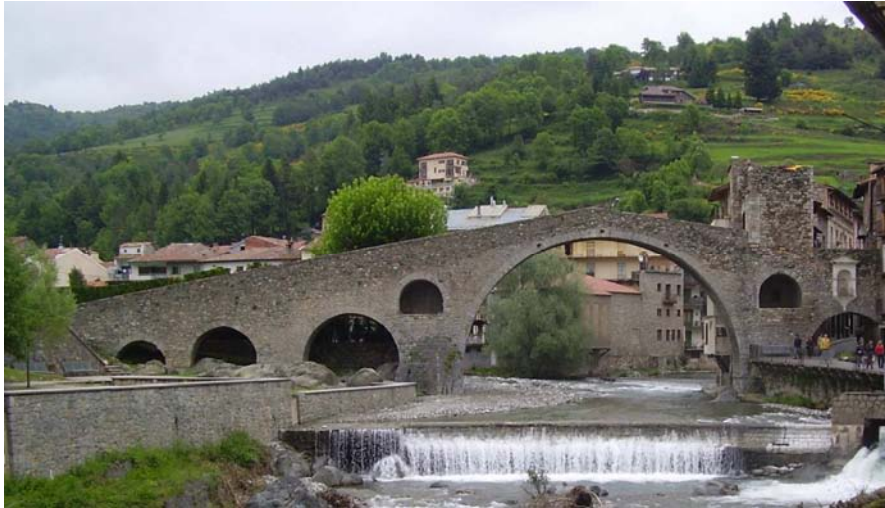
Imagen 2.1 vista general desde aguas abajo
