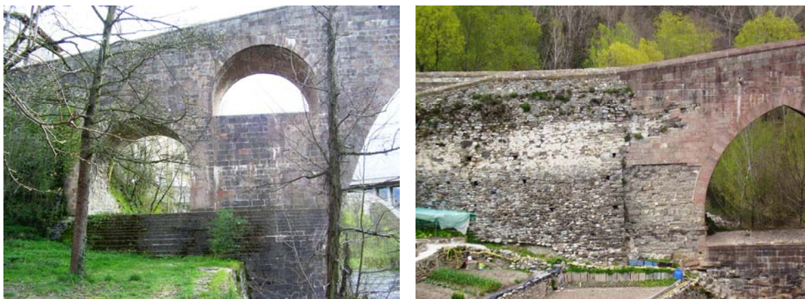
Imagen 3.3 A la izquierda: arco primero, arquillo y tajamar en la orilla izquierda 2
