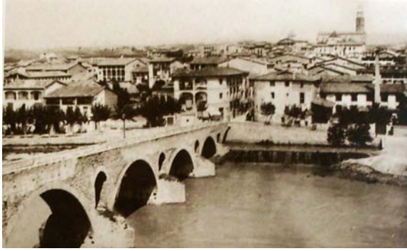
Imagen 4.6 A la izquierda: El puente a finales del XVIII, con anterioridad a la ampliación de ancho de la rasante. Al fondo el canal industrial y las aletas de contención de los terraplenes L'Abans
