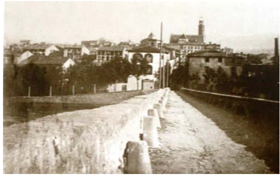
Imagen 4.6 A la izquierda: El puente a finales del XVIII, con anterioridad a la ampliación de ancho de la rasante. Al fondo el canal industrial y las aletas de contención de los terraplenes L'Abans
