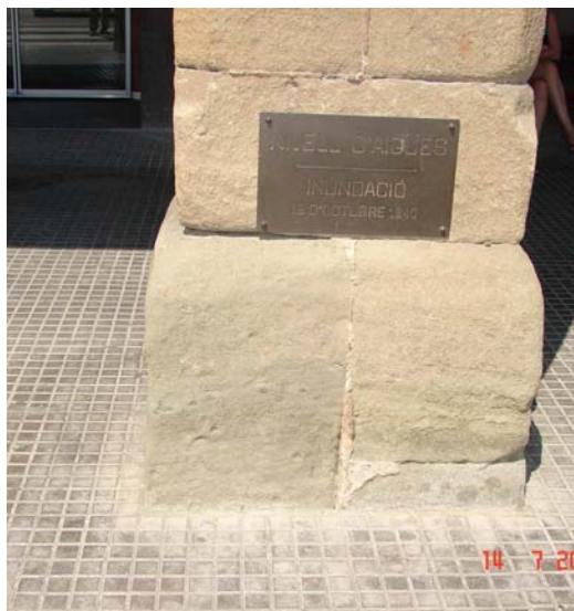
Imagen 4.19 Plaza del Fra Bernardí. Indicación de la altura del agua en las inundaciones del 18 de octubre de 1940, sobre los sillares del porticado del ayuntamiento.
