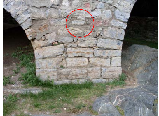
Imagen 2.17 A la izquierda : pérdida de material en la bóveda y en la boquilla del arco primero 15
