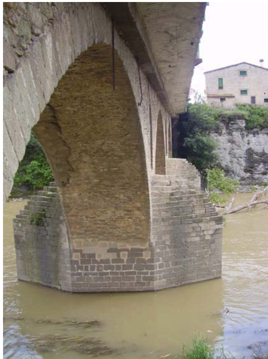
Imagen 4.4 Pila y arranque del arco cuarto.
