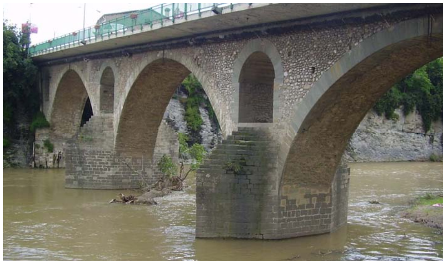
Imagen 4.3 Pilas cuarta, quinta y pila estribo orilla derecha
