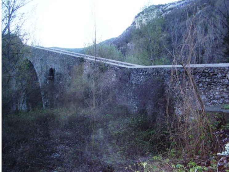
Imagen 1.3 Vista desde el margen derecho y aguas arriba: terraplén y segunda calzada.
