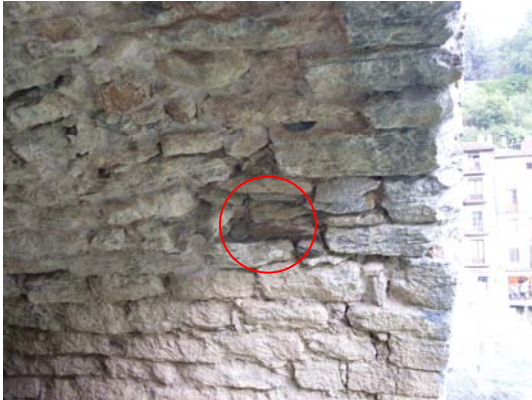
Imagen 2.17 A la izquierda : pérdida de material en la bóveda y en la boquilla del arco primero 15
