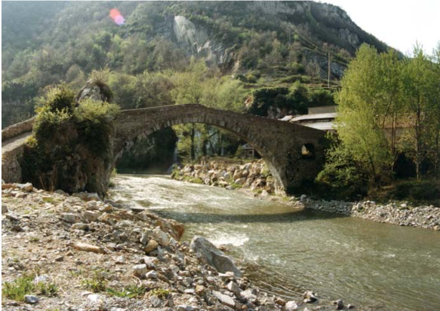
Imagen 1.1 Vista del puente desde el margen izquierdo aguas arriba Imagen .Ante de las obras de restauración realizadas por el Servei de Monuments de la Diputació de Girona en 1996. Arxiu Comarcal del Ripollès 1 .
