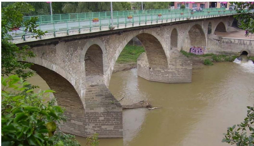
Imagen 4.1 Vista del puente desde aguas abajo.
