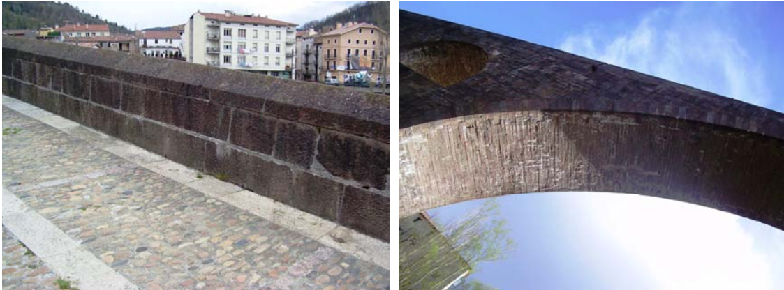
Imagen 3.5 A la izquierda: detalle del empedrado de la calzada y del acabado de los pretilos
