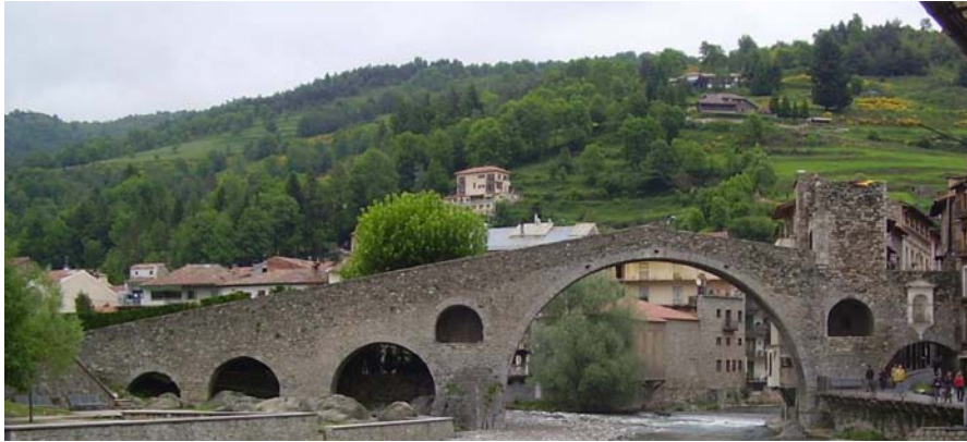
Imagen 2.3 vista general desde aguas abajo
