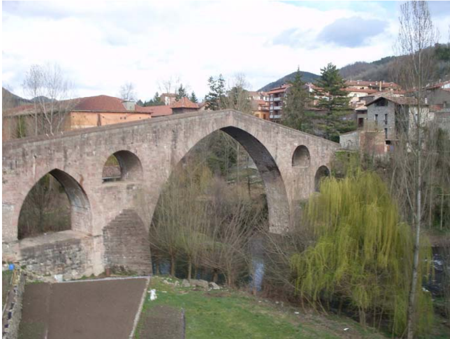
Imagen 3.1 Vista general del puente
