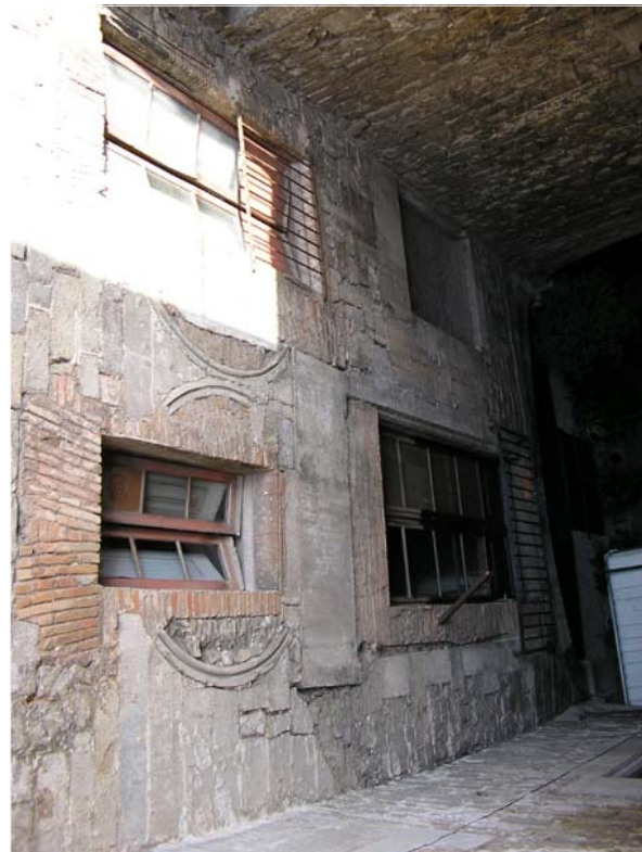
VISTA GENERAL DE LA FAÇANA
