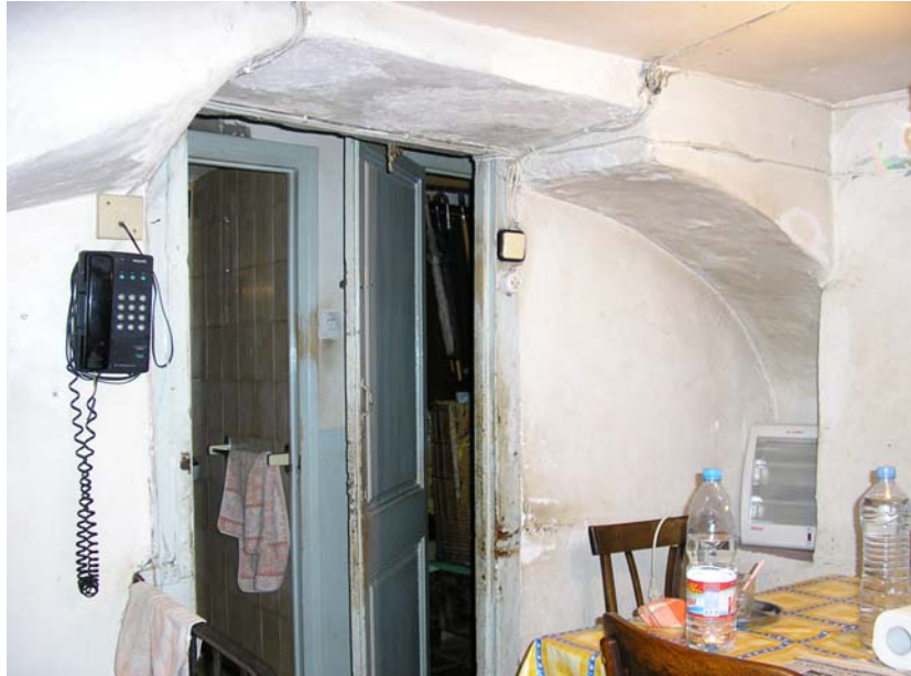
Figura 117. Arc localitzat a l'altell de la finca del c/ del Regomir nº 10. La seva llum abasta la totalitat de l'amplada de la finca.
