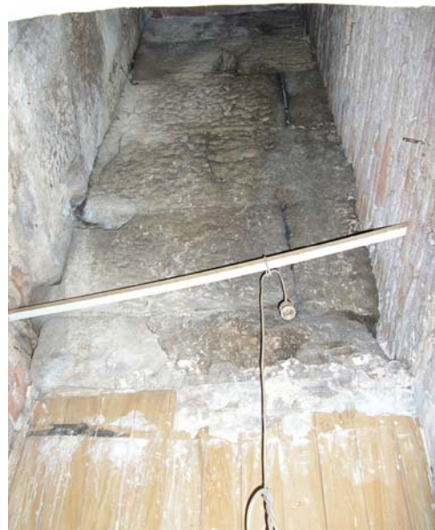
Figura 99. Finca c/ Ataülf nº 11 Parament lateral de la torre de defensa nº 40 localitzada a la Planta Baixa de la finca.
