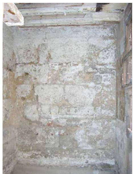
Figura 87. Finca c/ del Regomir nº 7-9. Parament lateral i part del basament de la torre nº 36 de l'encintat romà, visible a l'interior de la Planta Baixa de la finca.
