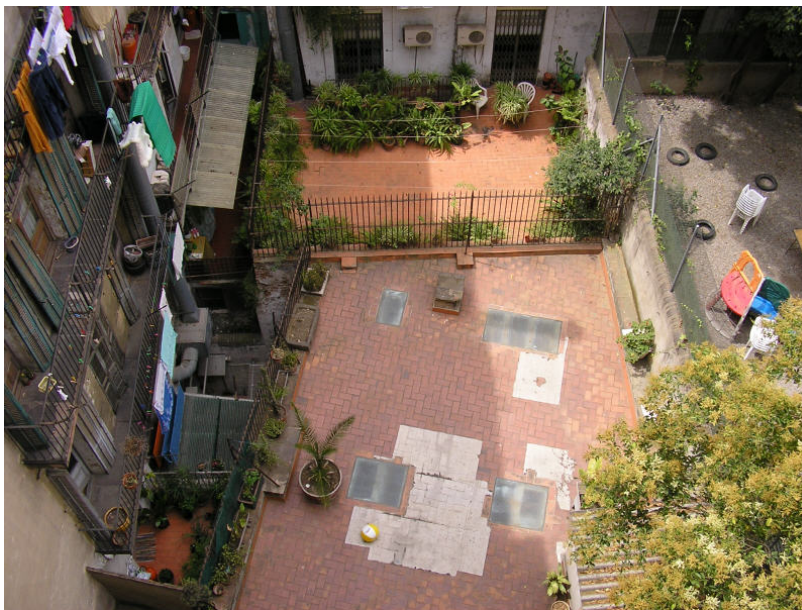
Figura 120. Fica c/ Ataülf nº 14. Pati interior d'illa ubicat a la part posterior de la finca i construït sobre l'estructura de l'arc descrit.
