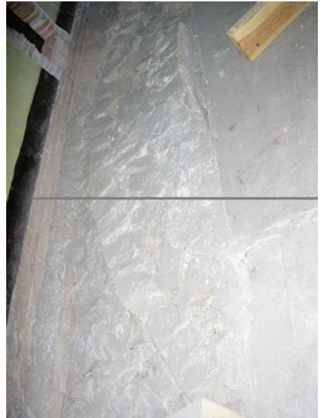
Figura 85. Finca c/ del Regomir nº 7-9. Traça del primer anell constructiu de la torre de secció circular nº 37 continguda en el forjat del terra de la Planta Principal (2on. nivell de l'edifici).
