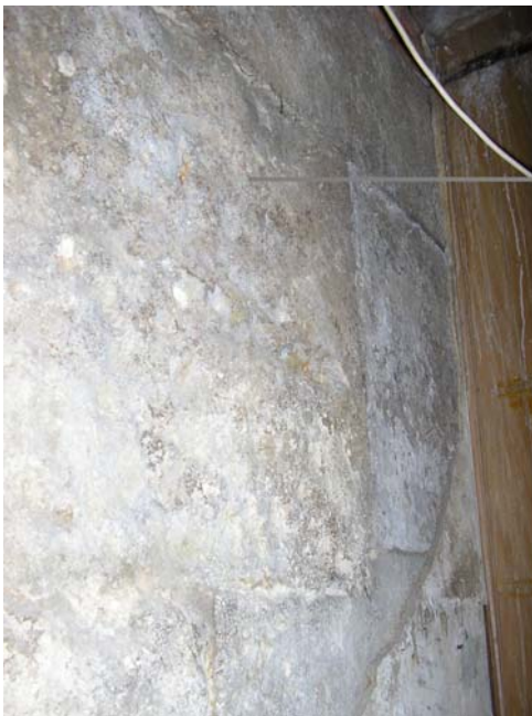
Figura 98. Finca c/ Ataülf nº 11 Tram de muralla romana entre la torre nº 40 i la nº 41 localitzat a la Planta Baixa de la finca.
