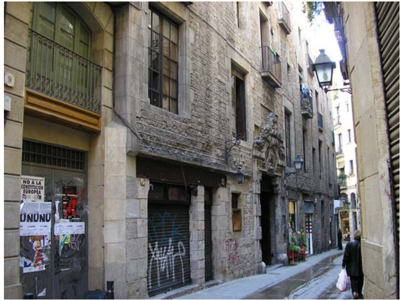
Figura 89. Finca c/ Regomir nº11-19 Façana que mostra la homogeneïtat compositiva, darrera la qual s'atresora una important complexitat estructural i distributiva.
