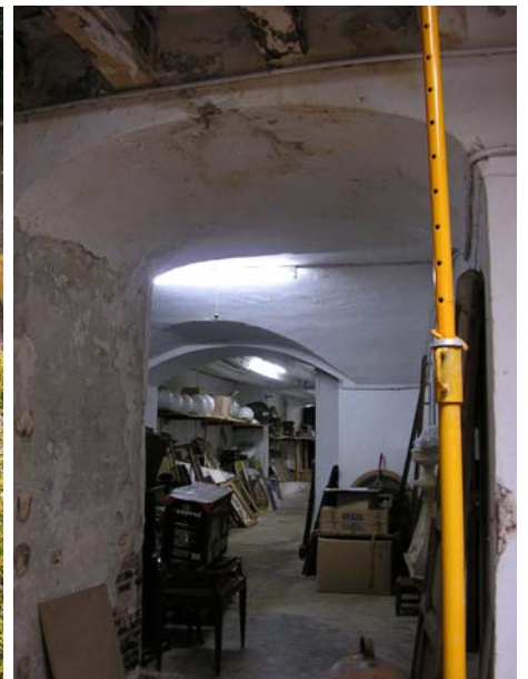
Figura 121. Finca c/ Ataülf nº 14. Estructura de mur portant de 90 cm. de gruix bastida sota la superfície del pati.
