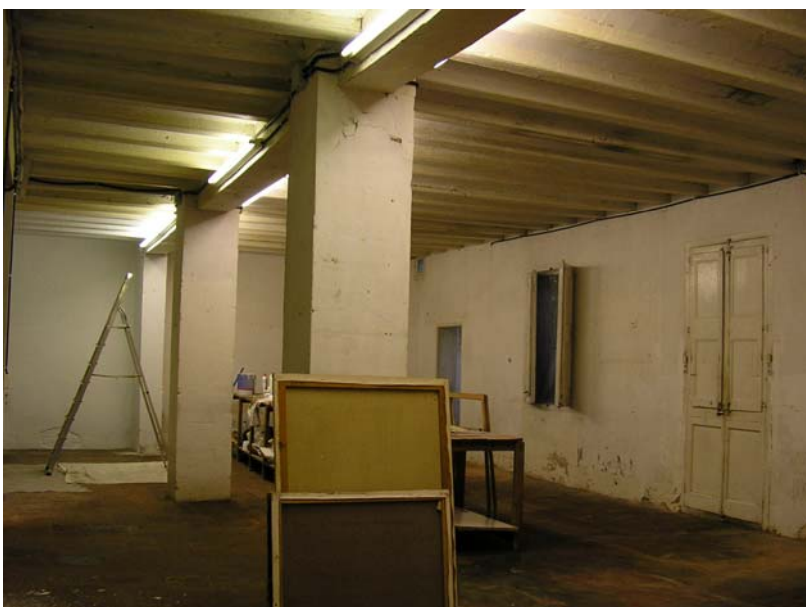
Figura 132. Finca c/ Ataülf nº 10. Pilars estructurals construïts en el punt mig del gruix de la traça de la muralla.
