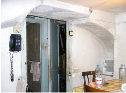
Figura 96. Finca c/ Regomir nº 10 Arc paral·lel a la façana de la finca localitzat a l'altell de la Planta Baixa
