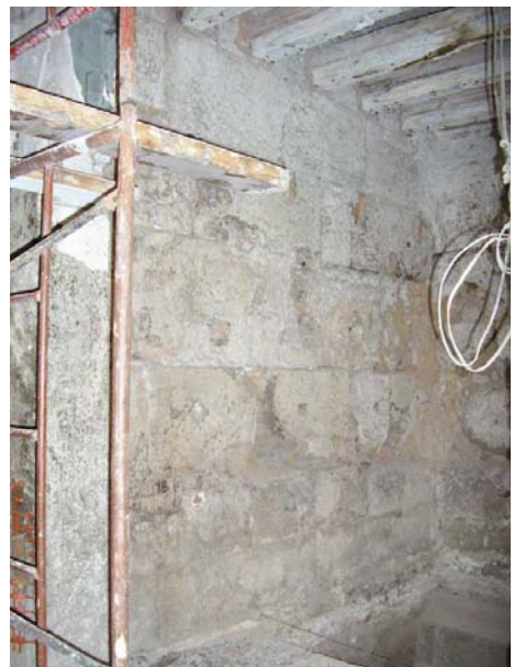
Figura 86. Finca c/ del Regomir nº 7-9. Paret mitgera amb la finca del c/ del Regomir nº 3-5 configurada per la pròpia muralla romana.
