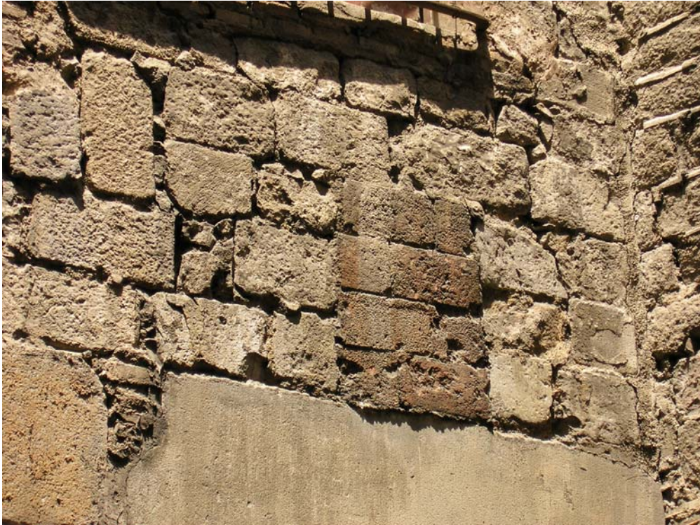
Figura 36 a. Finestra tapiada existent a Planta Primera, UE1. Mur nord-oest de tancament del pati d'accés. Finca carrer del Regomir nº 11-19.
