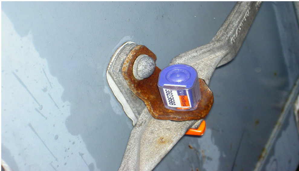
Fotografía nº 10. Precinto de seguridad
