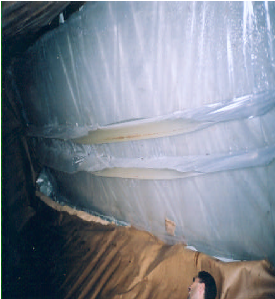
Fotografía nº 34. Agua procedente de la condensación del vapor de agua en un transporte de café en contenedor dry box de 20
