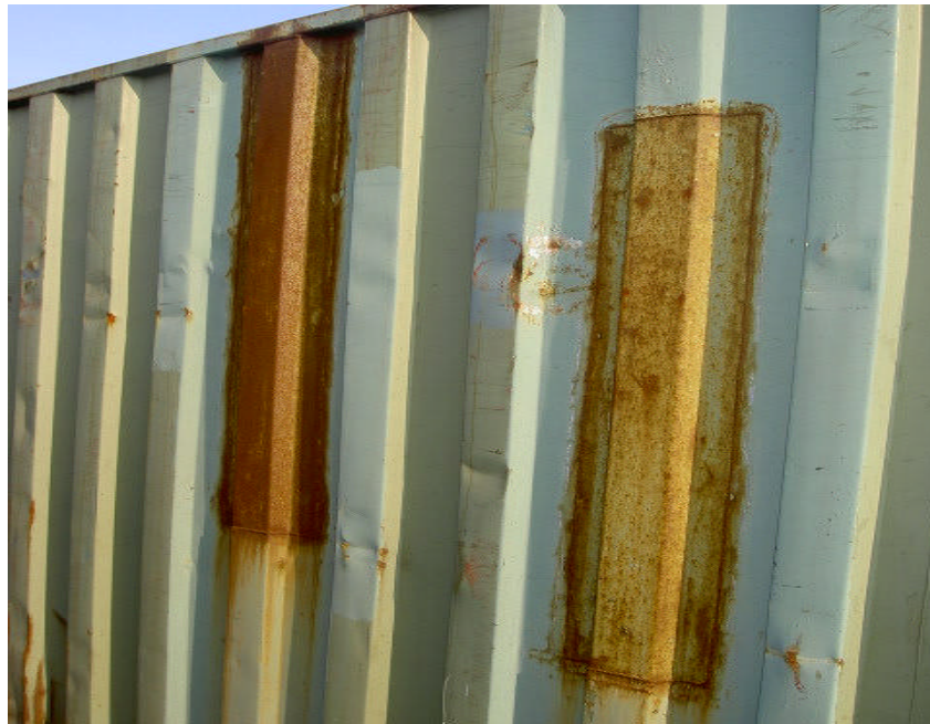
Fotografía nº 2. IMPROPER REPAIR (PLANCHA UTILIZADA SIN PINTURA DE IMPRIMACIÓN)
