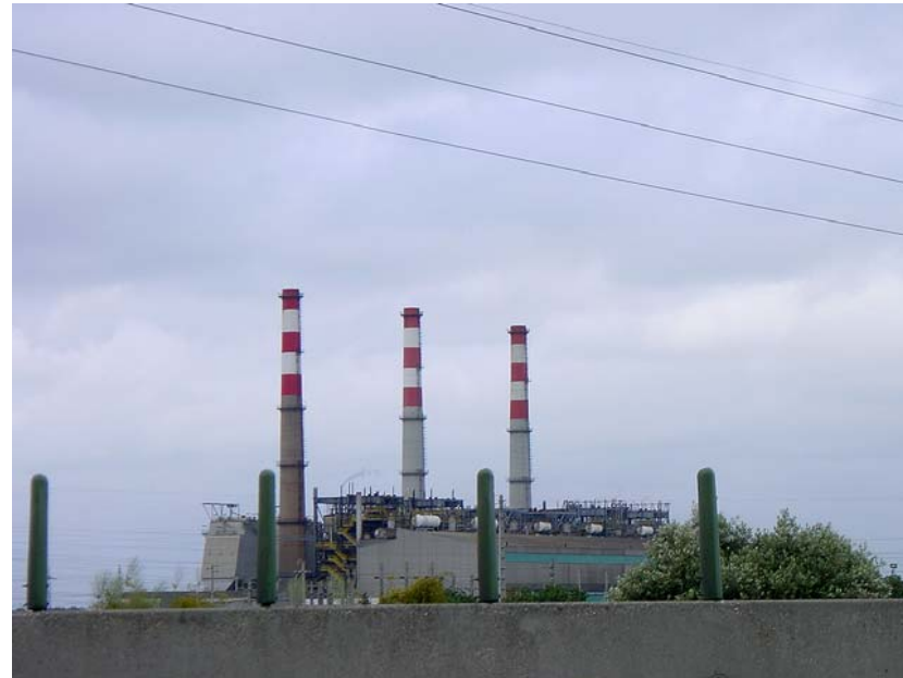
TRAYECTO 5-C |32. E.N. 115 Vialonga/ Vila Franca de Xira –Lisboa/ Autopista A1- 06.2002, fotografia S. Morgado, Estação Termo-eléctrica do Carregado.
