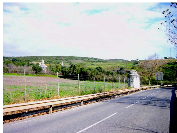
TRAYECTO 5-C |16. Cascais-Lisboa / Autopista A5- 01.2002, fotografia S. Morgado, carretera antigua, Carnaxide.
