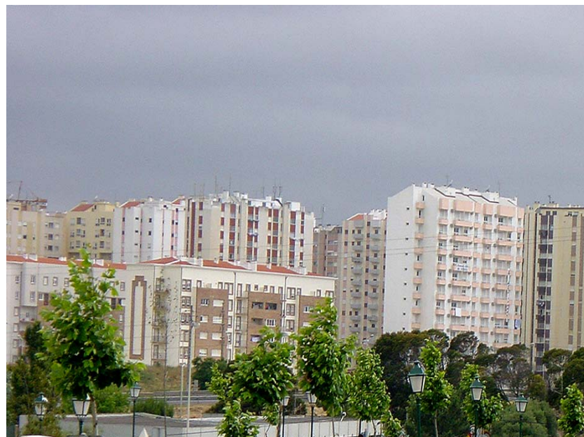
TRAYECTO 5-C |31. E.N. 115 Vialonga/ Vila Franca de Xira –Lisboa/ Autopista A1- 06.2002, fotografia S. Morgado, Vila Franca de Xira.
