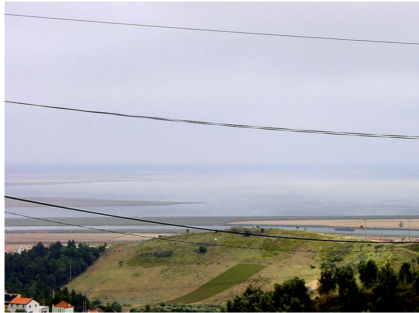
TRAYECTO 5-C |30. E.N. 115 Vialonga/ Vila Franca de Xira –Lisboa/ Autopista A1- 06.2002, fotografia S. Morgado, Catenarias de alta tensión y Lezíria, Vila Franca de Xira.
