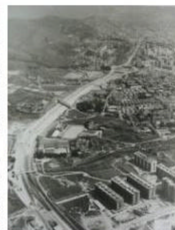
3.42. Segundo Cinturón entre el Paseo Vall d'Hebrón y la Vía Favencia en 1984.
