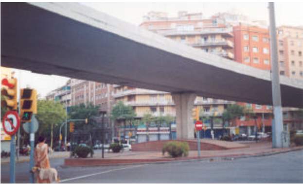
1.14. Vía segregada en viaducto. Ronda del MIG a su paso por Guinardó.
