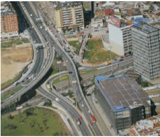
1.21 y 1.22 Las diferencias de accesibilidad y visibilidad en un cruce de calles y en un nudo de enlace de vías segregadas. Plaza Lluc Major y antigua Plaza Cerdà. Barcelona
