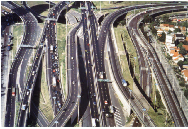
1.20. Enlaces en la Autopista del Sol. Buenos Aires
