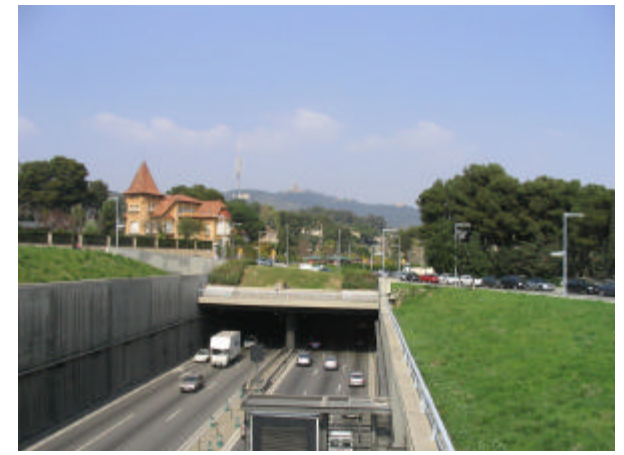
1.15. Vía segregada en túnel. Ronda de Dalt a su paso por Pedralbes.
