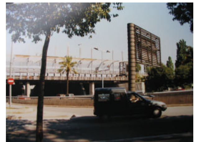
1.10. Pasarela peatonal sobre la Ronda de Dalt, correspondiente al cruce de la Av. Meridiana.
