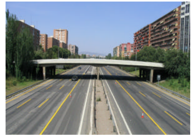
1.16. Vía segregada en trinchera. Av de les Corts Catalanes.
