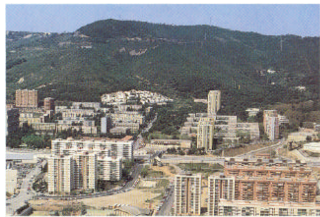
2.02. Discontinuidad entre urbanizaciones diferentes. Polígonos yuxtapuestos en el área de el Valle d'Hebrón, Barcelona, años 80s
