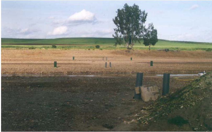
Figura 1.7: Aspecte final de la zona un cop instal·lada la barrera permeable reactiva a Aznalcóllar.
