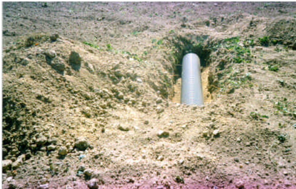
Figura E.10. Imagen de la tubería de PVC y de la zanja realizada para enterrarla en el terreno.
