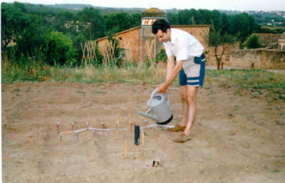
Figura E.7. Imagen que muestra cómo se genera la fuga de agua.
