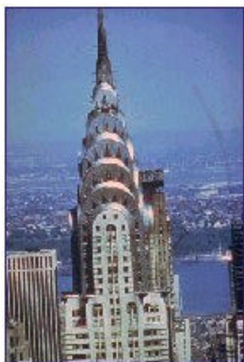
Figura 2-4. Edificio Chrysler (ESDEP, 2000).
