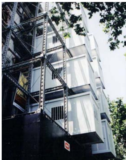
Edificios temporales de apoyo a obras de rehabilitación montados sobre estructura independiente a la manera de un cajón de botellas. Arriba, París. Abajo, Barcelona.
