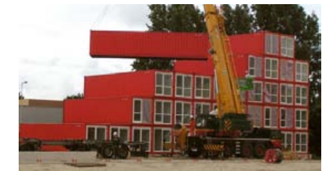
Viviendas para estudiantes Tempohousing (bajo la marca local de Keetwonen), realizadas con contenedores de transporte reciclados en el centro de Ámsterdam, Holanda
