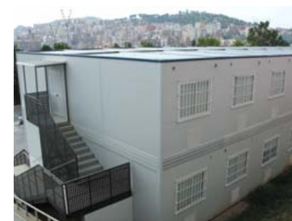
Edificio temporal de ampliación de servicios en la ciudad sanitaria de la Vall d'Hebron, Barcelona, realizado con módulos ligeros de fabricación española.
