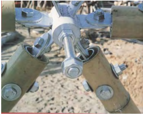
318.1. Uniones mecánicas en bambú (Renzo piano derecha)
