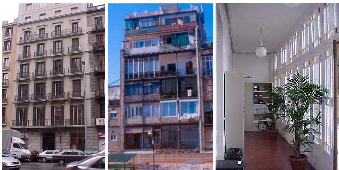
Fig. A3.1. Façana al carrer Aragó, façana al pati interior i interior de la galeria
