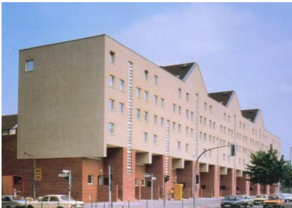
Vista da fachada principal
