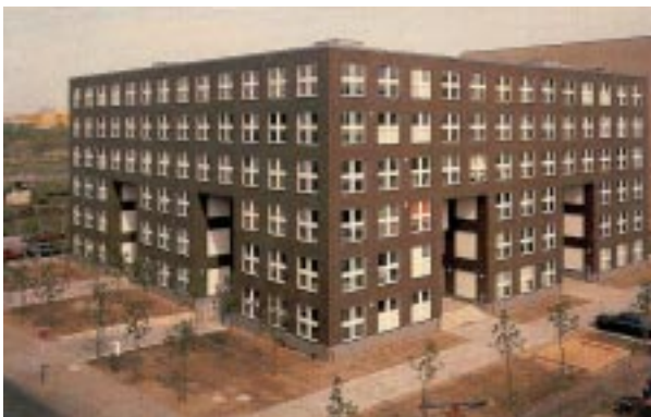
Vista do conjunto
