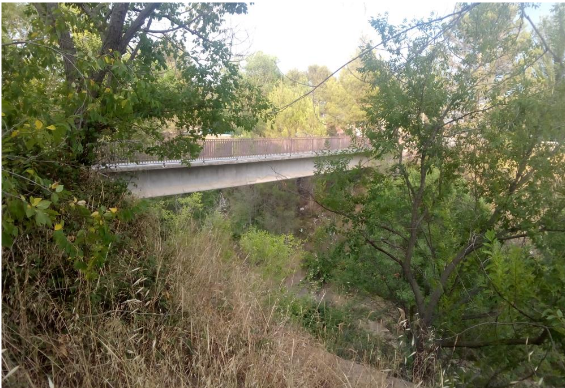
Imagen 3. Estado actual de la pasarela peatonal (Fuente Elaboración propia).
