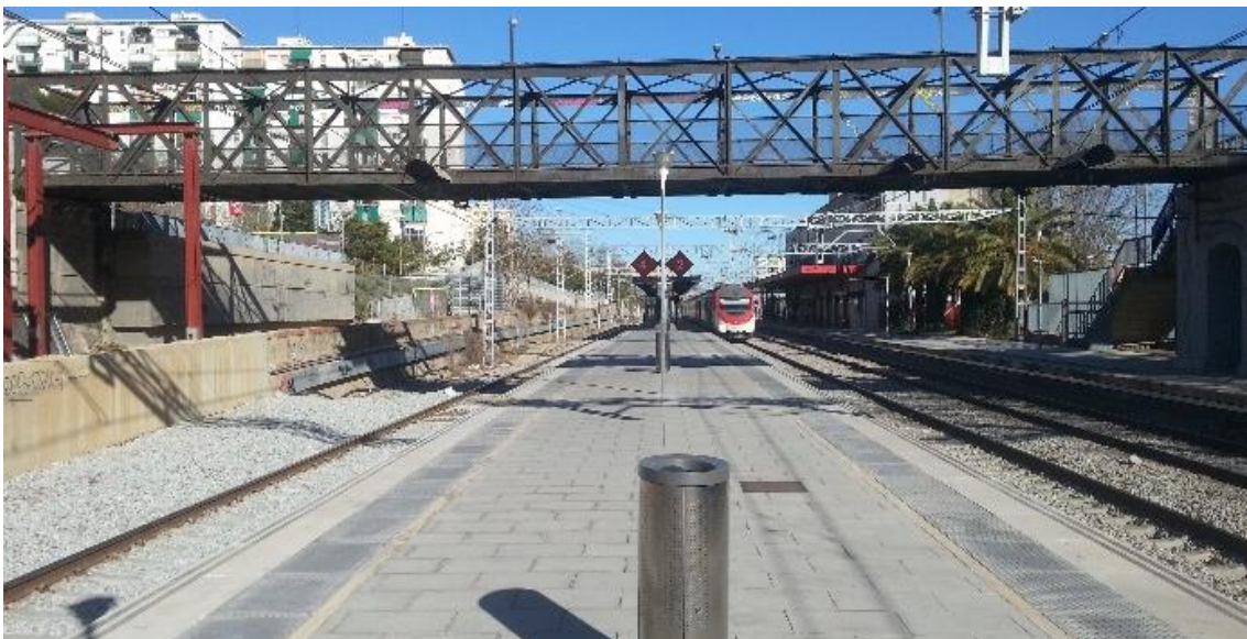
Imagen 5. Pasarela en l'Hospitalet del Llobregat (Fuente Elaboración propia).
