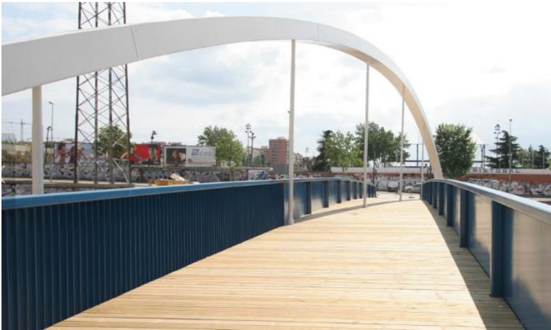
Imagen 16. Pavimento de madera (Pasarela de la Amistad, Terrassa) (Fuente Eng.
