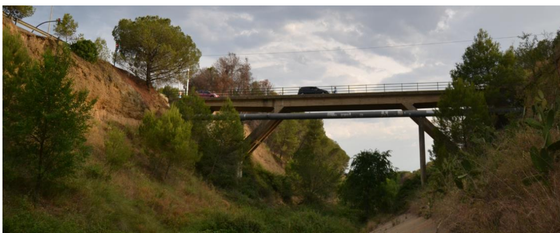
Imagen 9. Estado actual del puente de Can Gonteres (prolongación del camino Romeu de Montserrat) (Fuente Elaboración propia).
