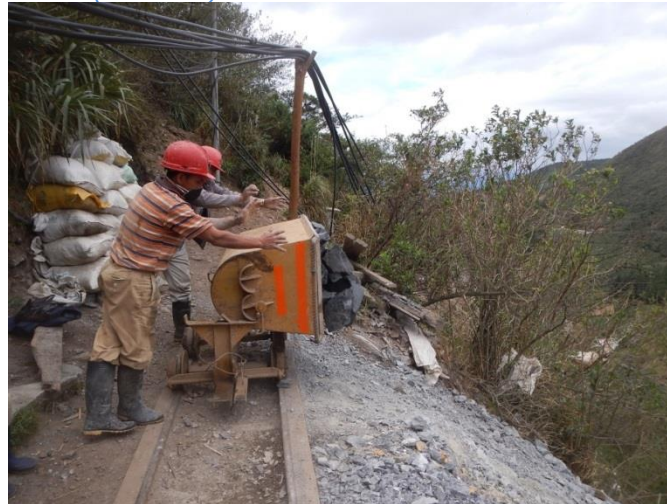
Fig. 7. Dipositant l'estèril a l'escombrera.
