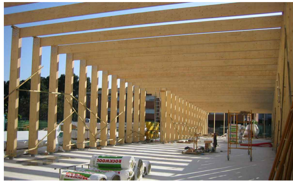
Construcció de la pergola amb pòtics de fusta laminada
