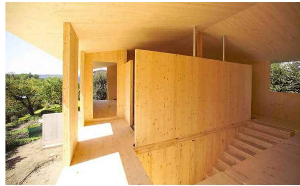
Construcció del bar amb panells KLH
