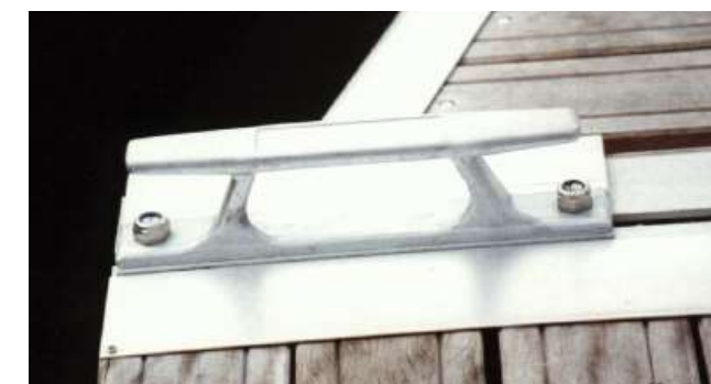
Figura 4. Detalle de cornamusa a colocar
