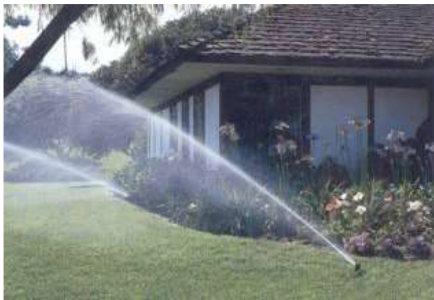
Sistema de riego por aspersión automático emergente. (Rociador o difusor) 2
