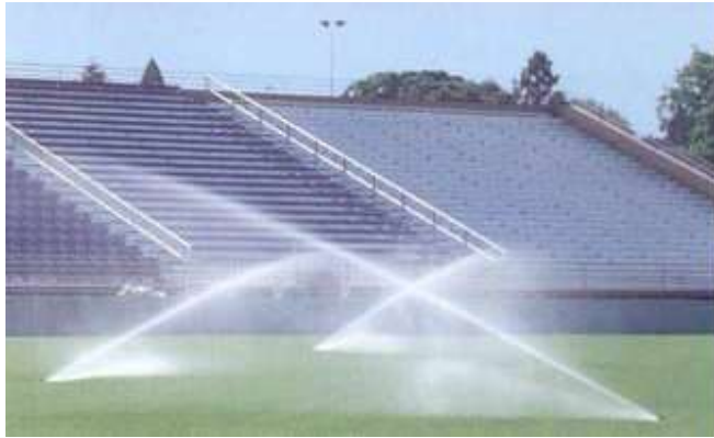
Sistema de riego por aspersión automático emergente. (Rotor o aspersor) 1
