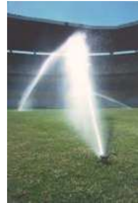
Sistema de riego por aspersión automático emergente. (Rotor o aspersor) 1
