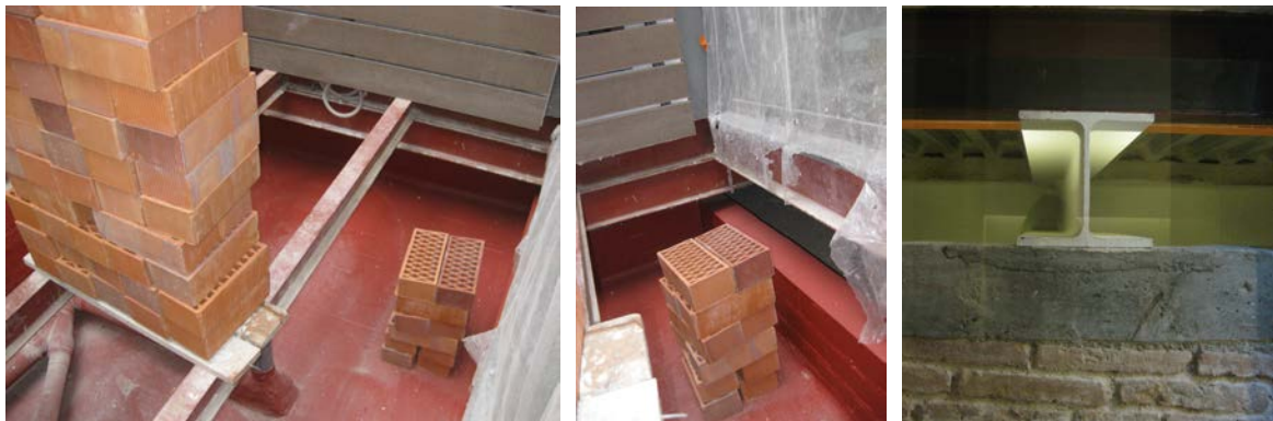
Figura 8: Remontas recientes. Detalles de la conexión entre edificio original y remonta. Fincas en c/ Girona 81 y c/ Roger de Llúria 41 [15].
