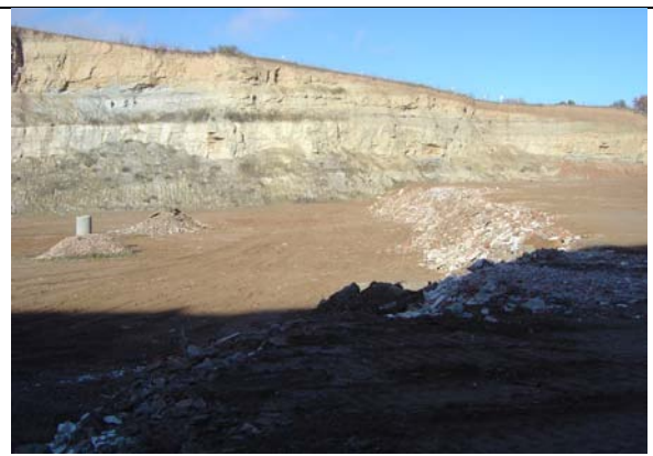
Fig. 2.2.- Frente del depósito y tubos para posible salida de biogás
