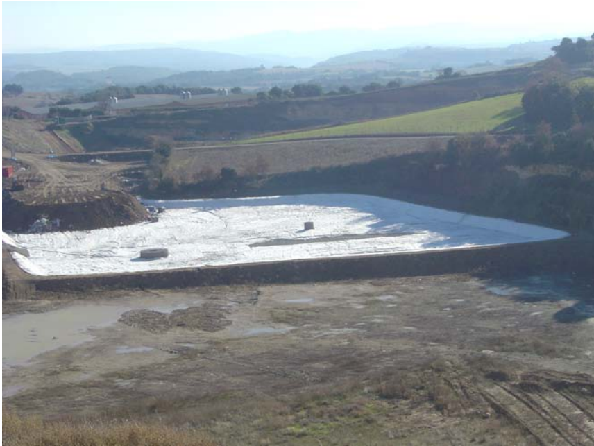
Fig.2.3.- Vista de la zona impermeabilizada del depósito de residuos industriales.
