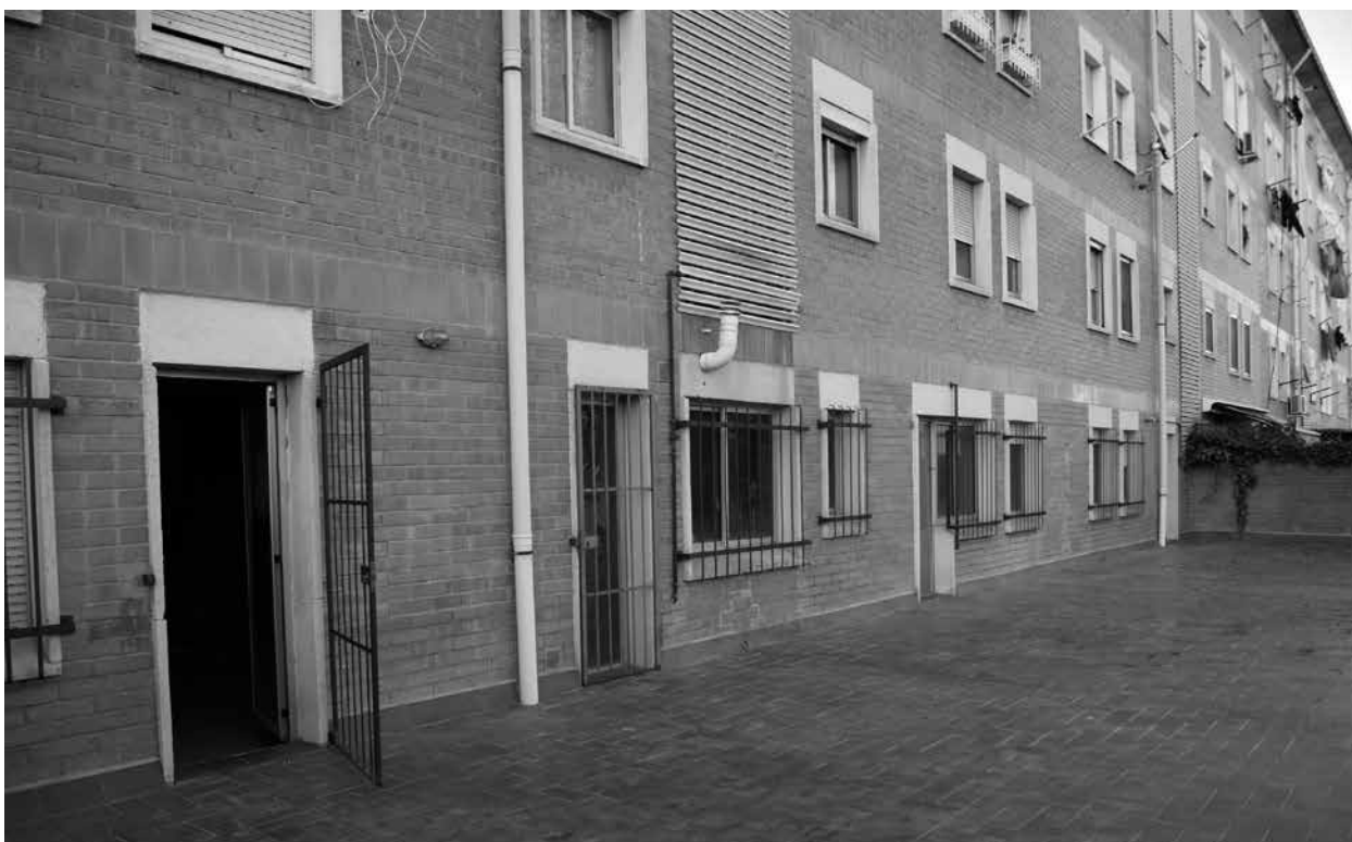
Figura 2. Vistas exteriores de Can Tussell, estado actual antes de empezar las obras.
