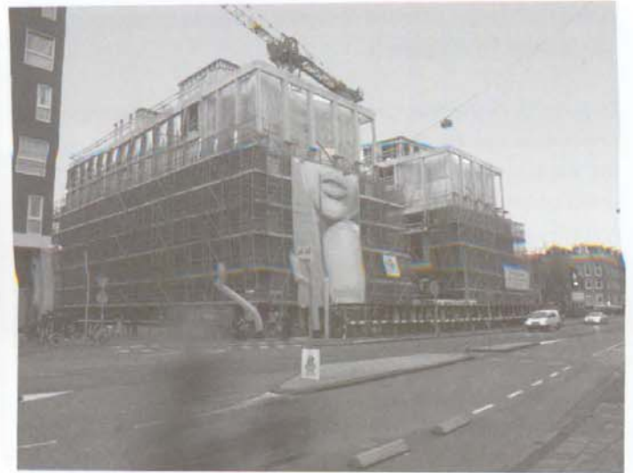
PROYECTO EN CONSTRUCCIÓN. SOLID OUD WEST
