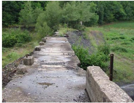
FOTOGRAFIA 8. PARADA 4 Un aspecte actual del pont per on s'iniciava la línia fèrria de les Mines de Malpàs. Juliol 2002
