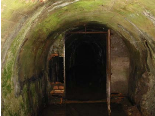
FOTOGRAFIA 5. PARADA 4 Restes de les tremuges internes de les Mines de Malpàs Juny 2009
