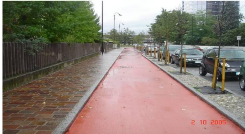
Imagen 7. Aplicación de mezcla fotocatalítica con base cemento
