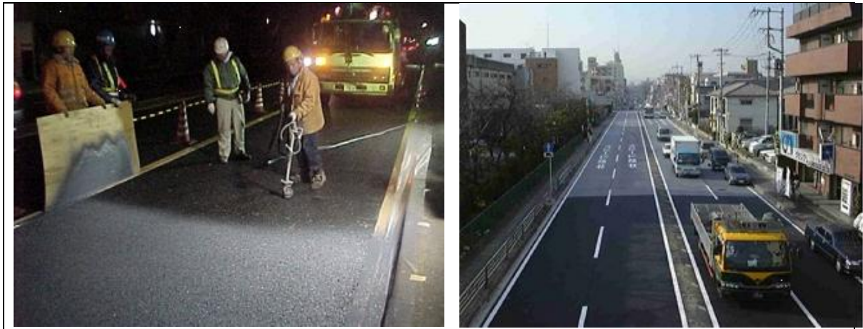
Imagen 6. Recubrimiento fotocatalítico cementiceo sobre calzada. (Construcción y Materiales de Construcción, 25 (2011), 588)
