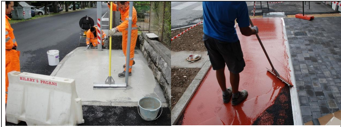
Imagen 5. Aplicación de capa de mortero y lechada para restauración. Fabricante: Ecobeton Italy
