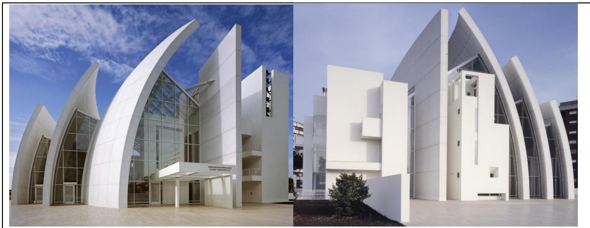
Imagen 16. Fachada frontal y trasera de la iglesia Dives in Misericordia hecha con hormigón fotocatalítico
