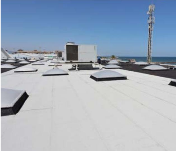
Imagen 12. Cubierta Leroy Merlin
