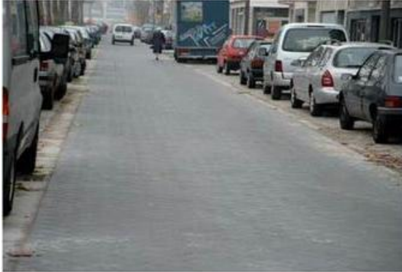
Imagen 20. Carretera de bloques con \text{TiO}_2
