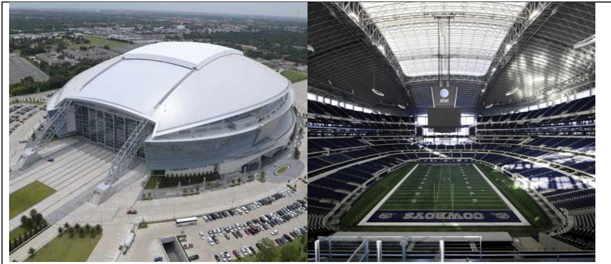
Imagen 19. Estadio AT & T con techo retráctil de membrana fotocatalítica en Texas, USA
