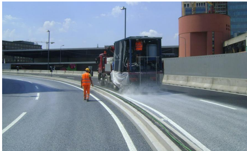
Imagen 8. Tratamiento fotocatalítico sobre calzada. Fabricante: Italcementi
