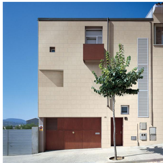
Imagen 4. Fachada de gres fotocatalítico
