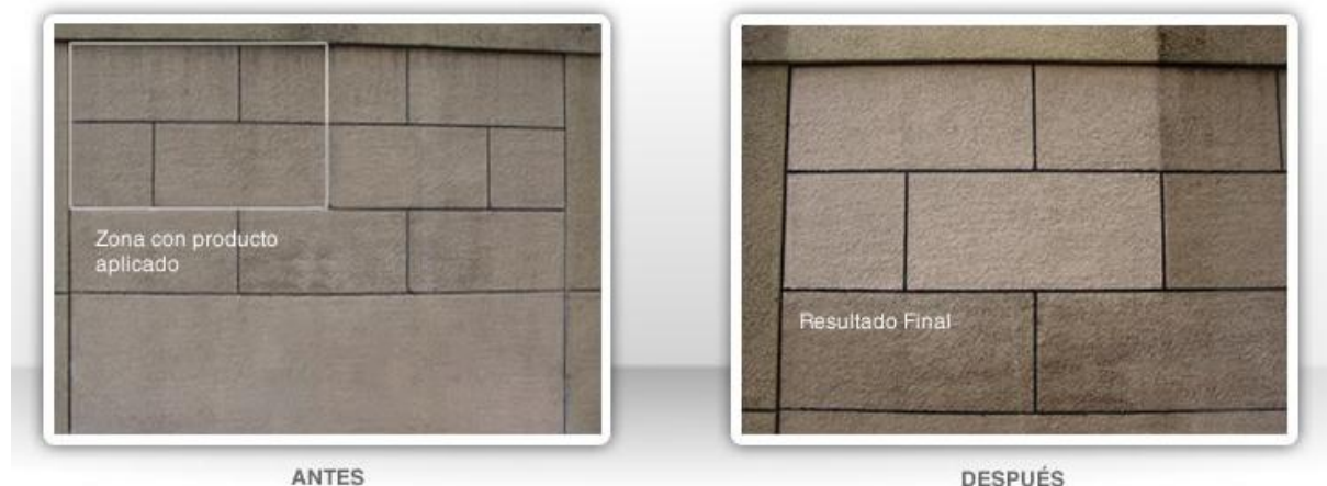
Figura 6. Autolimpieza de fachada tras aplicar un producto a base de nanopartículas de TiO 2
